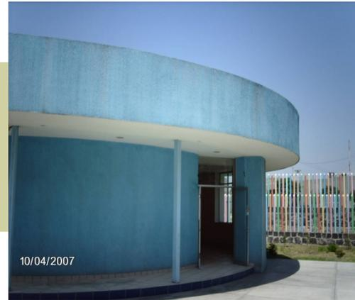
ELEMENTOS VERTICALES: COLUMNAS DE CONCRETO ARMADO Y MUROS DIVISORIOS.
