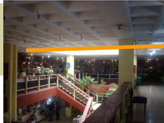
ELEMENTOS VERTICALES: COLUMNAS DE CONCRETO ARMADO Y MUROS DIVISORIOS DE TABIQUE ROJO.
