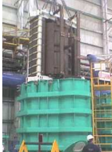
Figura 5-8: Ensamble del reactor
