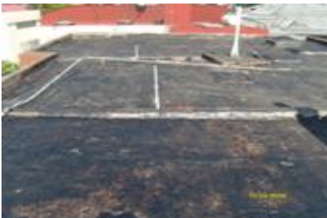
Fotografía 8. Nos muestra la forma correcta de cómo debe quedar la superficie ya limpia una vez retirado el sistema anterior.
