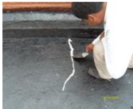
FOTOGRAFÍA 2 MUESTRA LA IMPRIMACION Y SELLADO DE LA SUPERFICIE.
