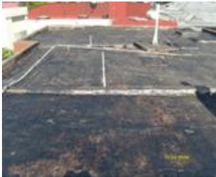
FOTOGRAFÍA 1 MUESTRA LA LIMPIEZA Y PREPARACIÓN DE LA SUPERFICIE .
