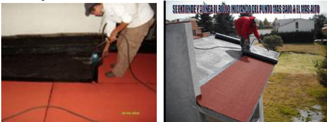
Fotografía 14 Nos muestra la forma correcta de la aplicación de impermeabilizante prefabricado por medio de soplete.
