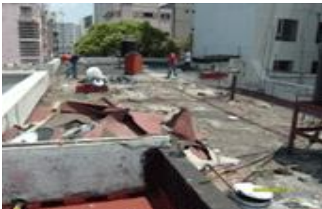
Fotografía 4. Se muestra la forma correcta de como para la preparación de un nuevo sistema es necesario retirar el sistema anterior, cuando este se encuentra mal adherido.
