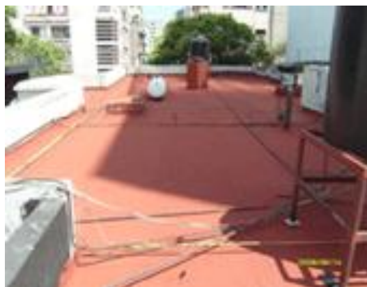
Fotografía 11 nos muestra el aspecto final de nuestro sistema acrílico.
