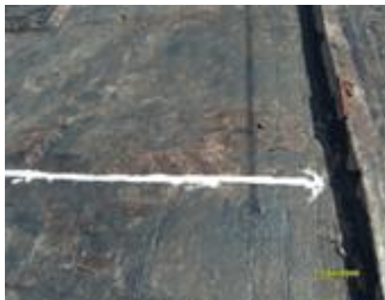
Fotografía 10. Nos muestra la forma correcta de cómo aplicar el sellador después de haber imprimado la superficie y dejado secar.
