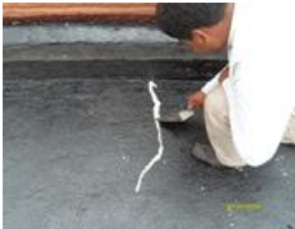
Fotografía 13. Se muestra la forma correcta de cómo aplicar el sellador después de haber imprimado la superficie y dejado secar.
