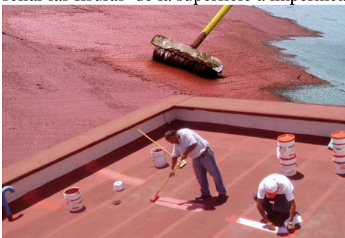
Fotografía 7. la parte superior muestra como después de haber llevado a cabo el procedimiento de la colocación de las emulsiones asfálticas con sus respectivas membranas de refuerzo, se llevo a cabo la aplicación de pintura como acabado después de secar las capas de asfalto.
