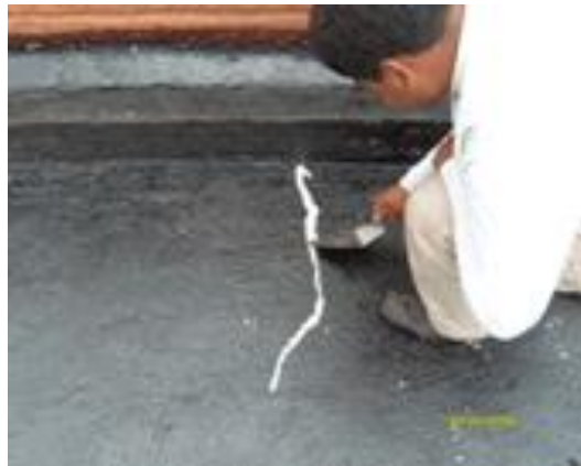
Fotografía 10. Nos muestra la forma correcta de como aplicar el sellador después de haber imprimado la superficie y dejado secar.
