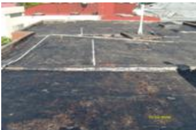
Fotografía 5. Se muestra la forma correcta de como debe quedar la superficie ya limpia una vez retirado el sistema anterior.
