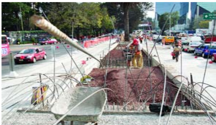
Obras del Metrobús Insurgentes Foto: skyscrapercity.com
