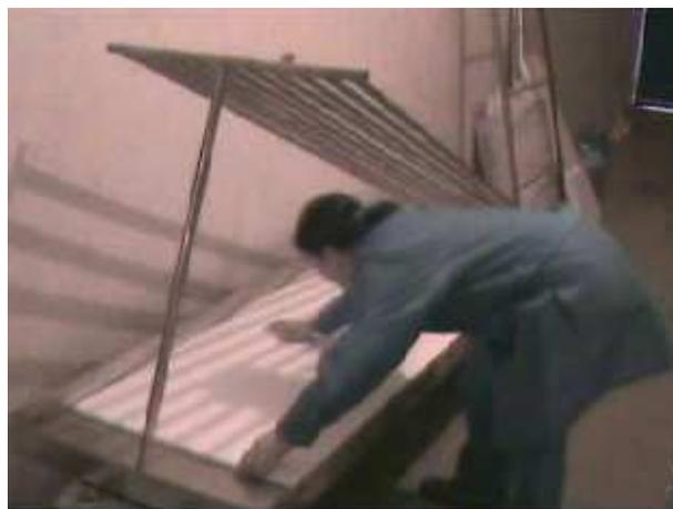
**Ilustración 10 COLOCACIÓN DE POLIESTIRENO EXPANDIDO**
