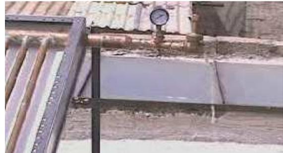
Ilustración 15 COLOCACIÓN DE MANÓMETROS
