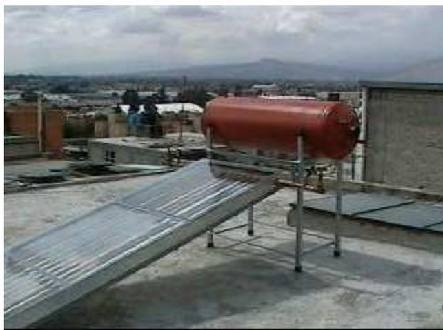
**Ilustración 22 COLOCACIÓN DEL TANQUE EN SISTEMA**
