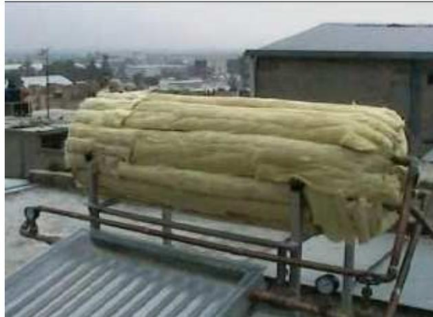
**Ilustración 24 RECUBRIMIENTO FIBRA DE VIDRIO**
