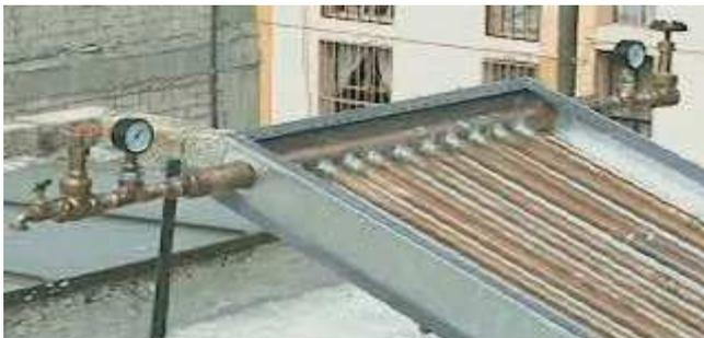
Ilustración 14 COLOCACIÓN DE MANÓMETROS
