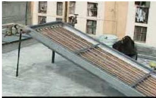
Ilustración 13 COLOCACIÓN DEL SERPENTÍN EN AZOTEA
