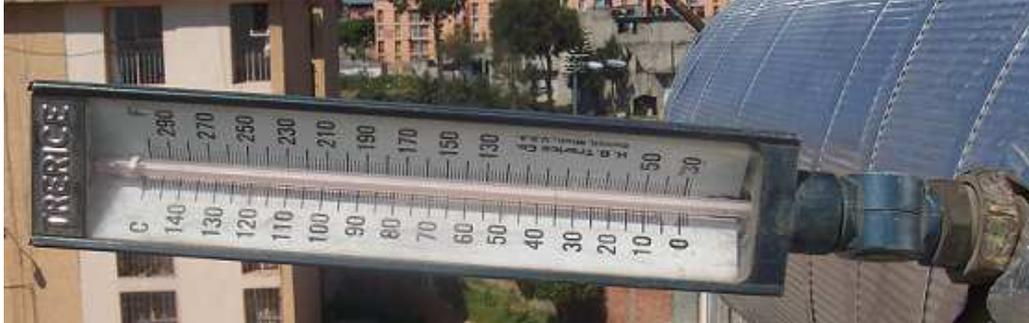
Ilustración 40 TERMÓMETRO EN EL TERMO-TANQUE
