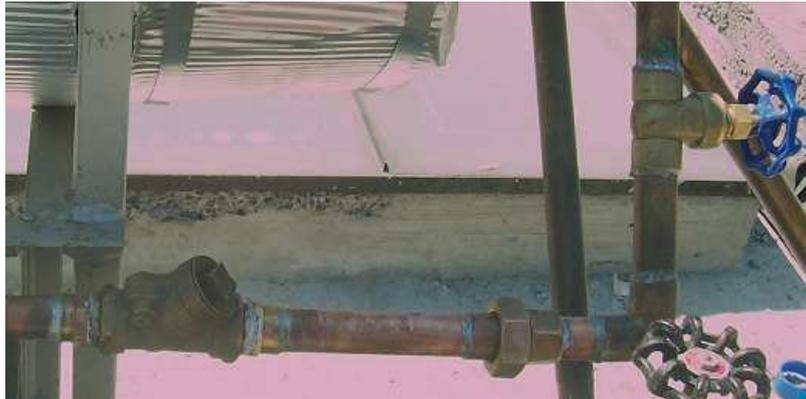
Ilustración 35 VÁLVULA DE NO RETORNO
