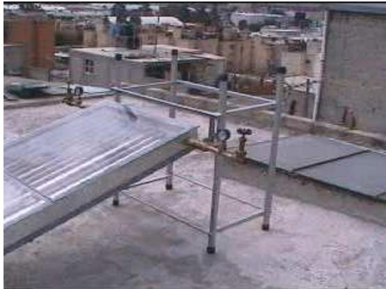
Ilustración 19 BASE DE ACERO DEL SISTEMA
