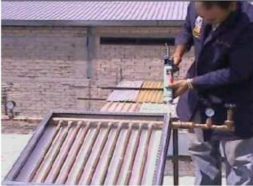
Ilustración 16 COLOCACIÓN DE SILICÓN
