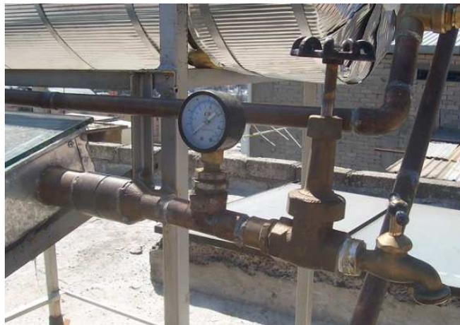
Ilustración 34 PURGA DE CABEZAL
