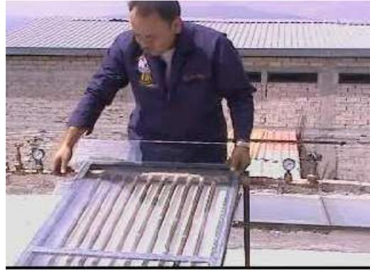
Ilustración 17 COLOCACIÓN DE VIDRIO
