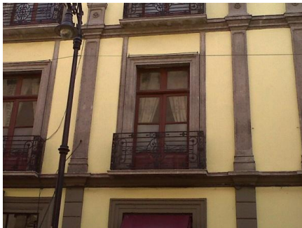
Balcón de fachada
