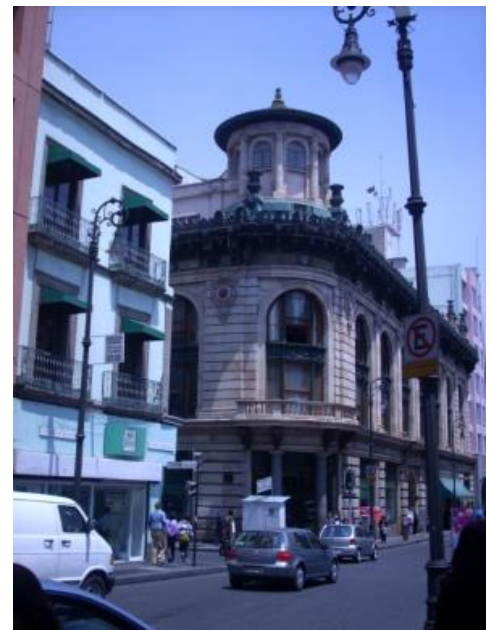
Foto 5 Casa Boker esquina de 16 de Septiembre e Isabel la Católica.
