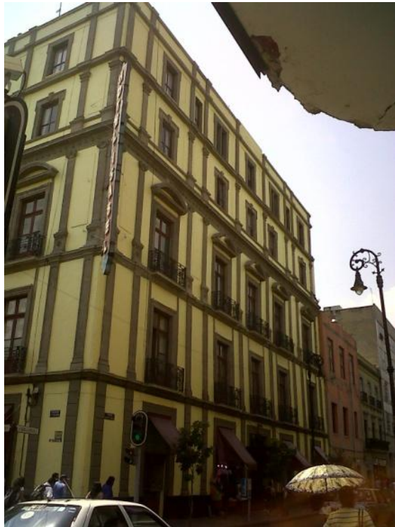
Fachada hacia la calle de Isabel la Católica
