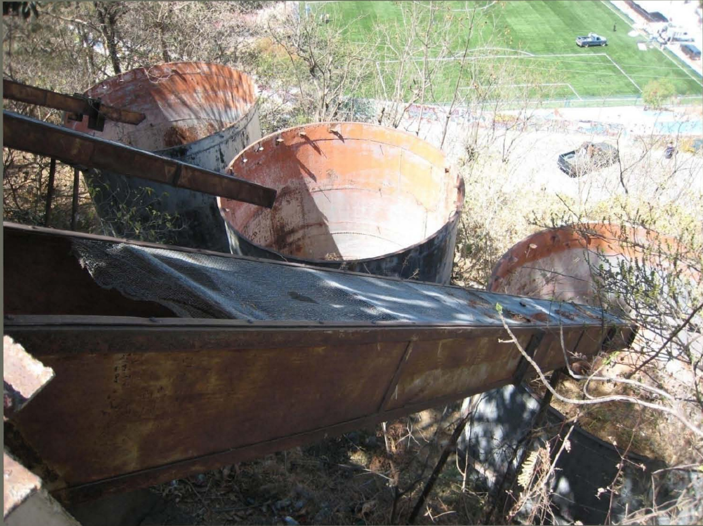
Tres silos metálicos usados para granos
