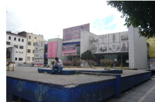
DESDE AYUNTAMIENTO VISTAS FACHADA NORTE
