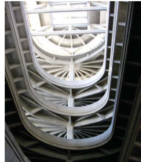
Vista de la espiral por donde bajaban los automobiles terminados en la fabrica. 2010.
