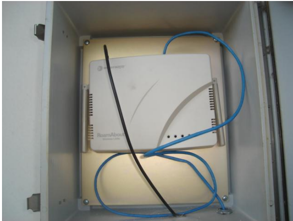
Fig. 3.11 Montaje del punto de acceso RoamAbout.
