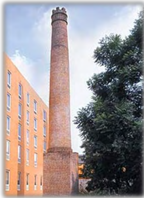
Fig. 1.4. Chimenea de Puebla.
