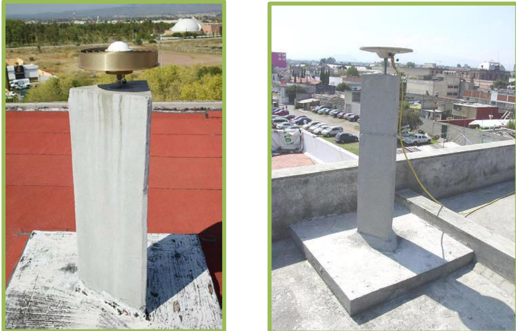
Fig. 2.17 Antenas de estaciones de la RGNA de INEGI.
