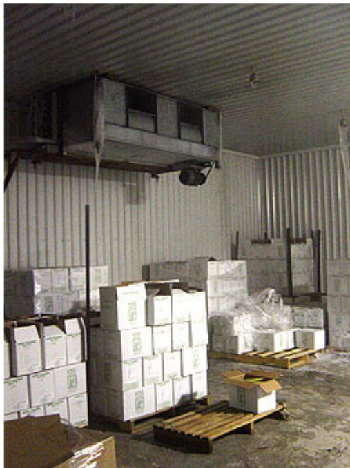
Figura 15. Cámara de refrigeración para mantener los aguacates a 3-7°C. Fuente: Dorantes, et al.
