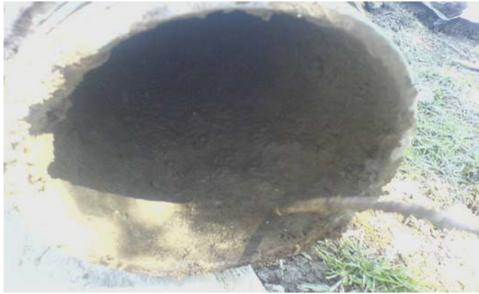
Se termina de perforar y limpiar la pila
