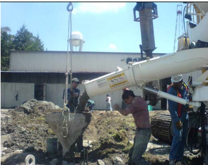
Se efectúa el colado de la pila
