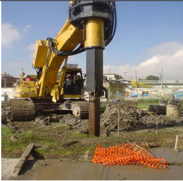
Se termina de perforar y limpiar la pila
