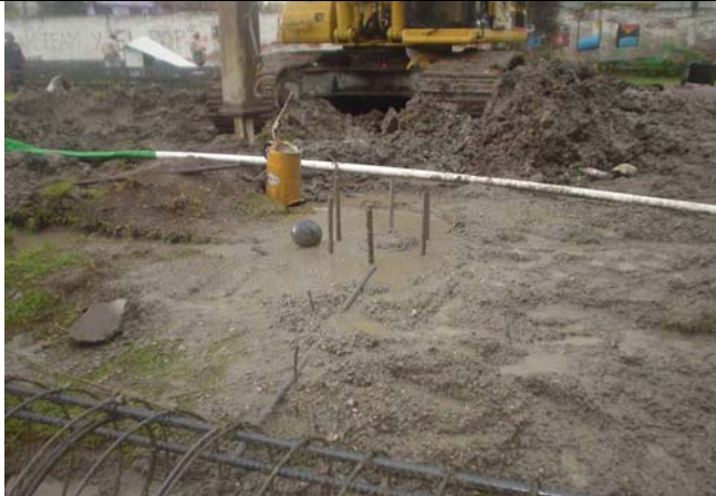
Se observa que el tapón hizo su función de que llegue el concreto limpio y no se disgregara.
