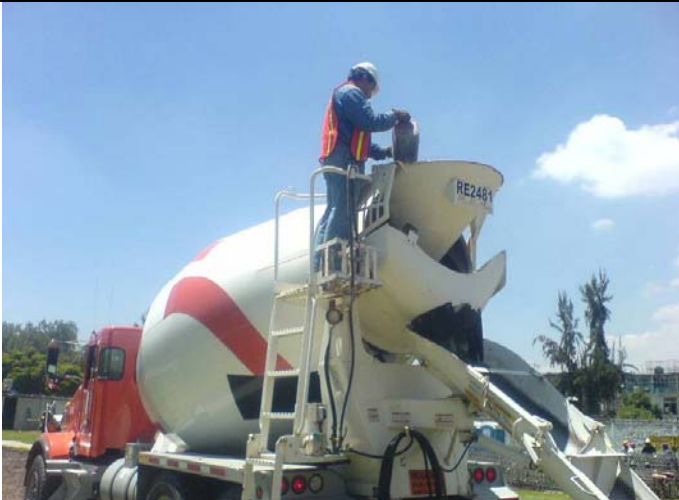
Se le agrega aditivo súper-fuidizante para elevar el revenimiento.
