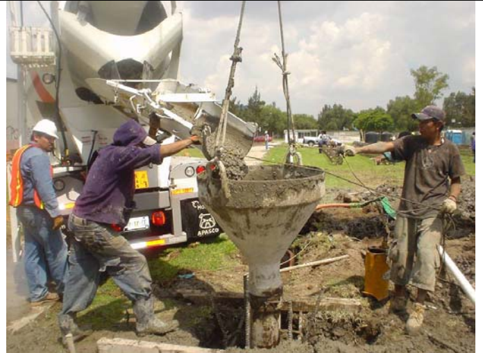
Se realiza colado de pila.
