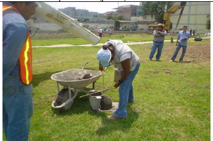
Se realiza prueba de revenimiento que es de 8.0 cm para el colado de la pila.
