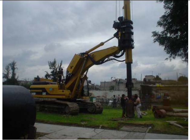
Se observa que ya se tienen unas pilas armadas y habilitadas.
