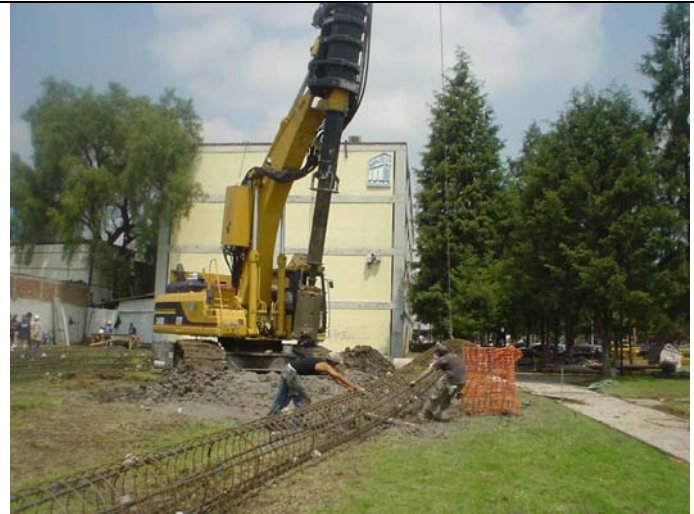
Se introduce armado de la pila cumpliendo las especificaciones de concreto tanto en la varilla como en la separación y la reducción a un 1mt del zuncho y teniendo los separadores (pollos).
