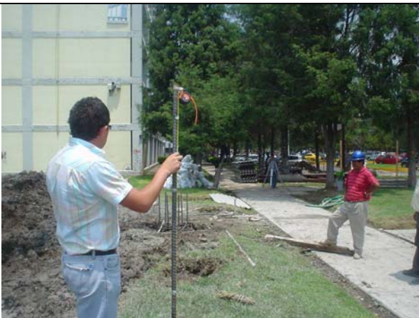
Con ayuda de topografía se centro y se ubico el armado de acuerdo al proyecto.
