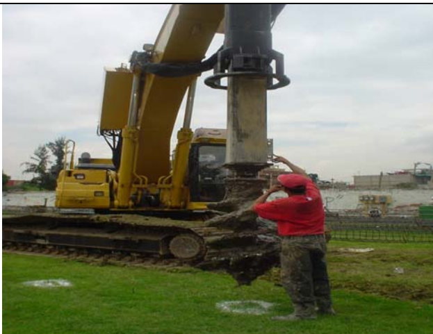
Se comienza a perforar pila
