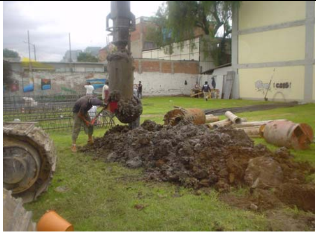
Excavación del barreno, en este día se llega a una profundidad de 9mts.
