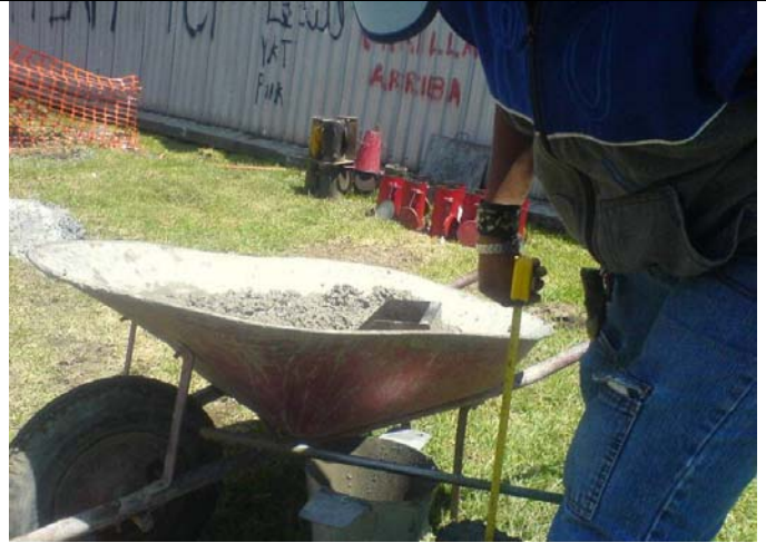
Prueba de revenimiento para el colado de la pila.
