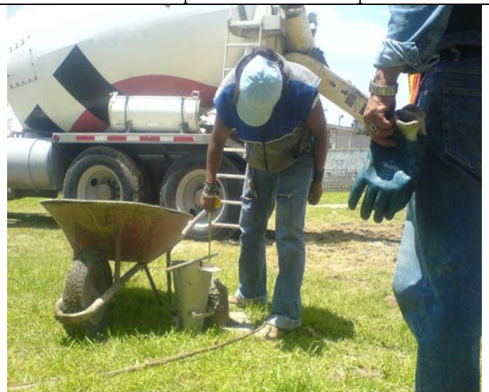
Prueba de revenimiento para el colado de la pila
