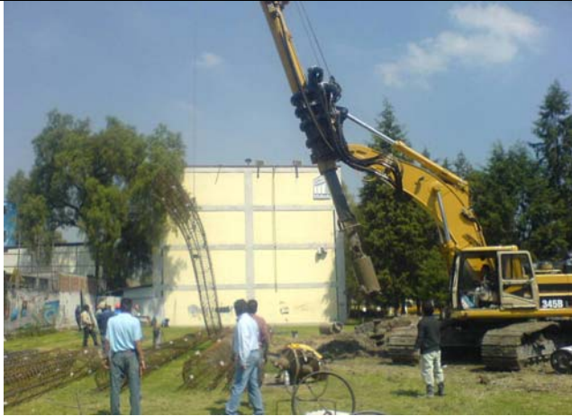
Armado para la pila que cumple con las especificaciones del proyecto.
