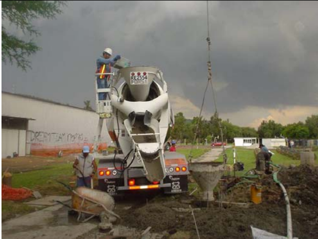
Se le agrega aditivo súper-fluidizante para elevar su revenimiento.
