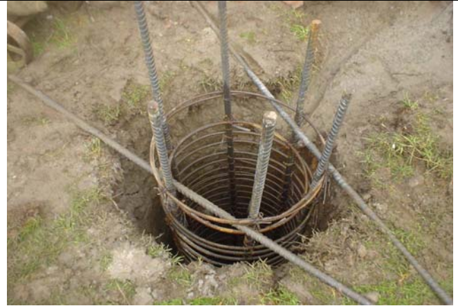
Para la pila se retiró el armado para limpiarla una vez mas ya que el día anterior hubo lluvia y no se pudo colar y se esta tomando estas precauciones.
