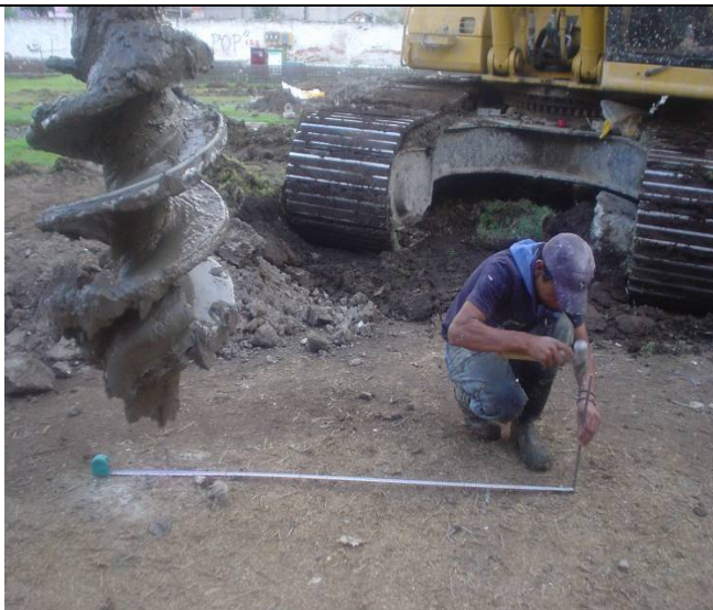
Comienzo de perforación de barreno para la pila
