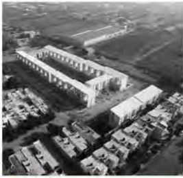
Vista aérea del conjunto
