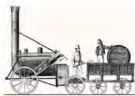
Locomotora del siglo XVIII impulsada por vapor.
