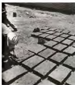
Fabricación de bloques de arcilla y tierra.
