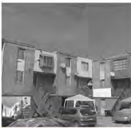
Vista de viviendas modificadas
