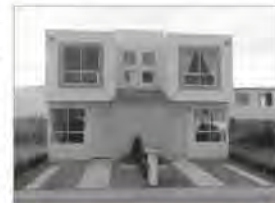
Conjunto de casas GEO en el estado de Veracruz
