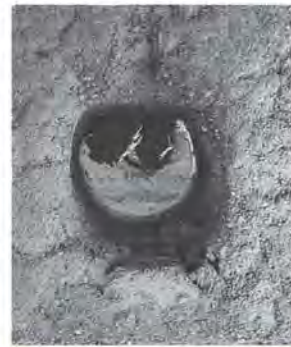
Orificios pequeños para paso de iluminación.
