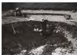
Extracción de tierra para la fabricación de bloques.
