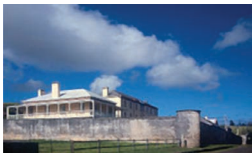
Edificios de la vieja cárcel de la isla Norfolk.
