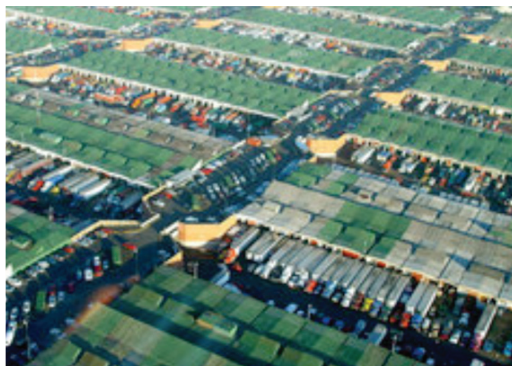
Subcentro urbano Central de Abastos.
