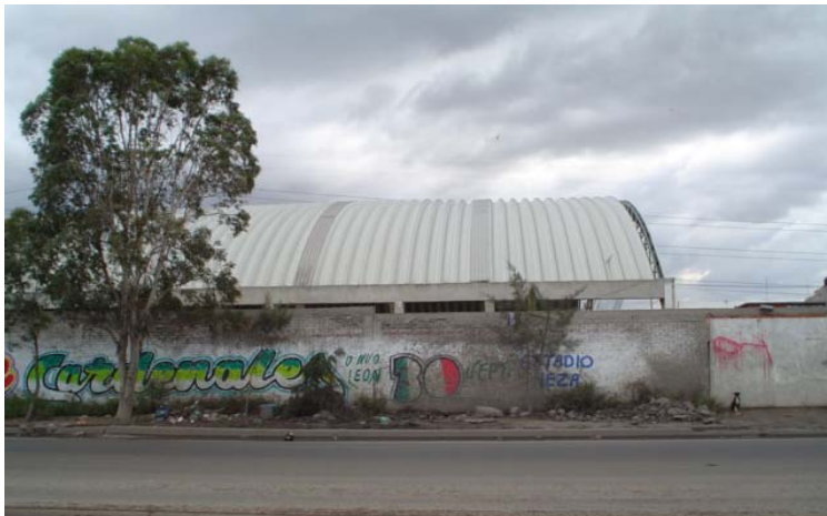
Foto 6.- Vista hacia el terreno desde el límite norte
