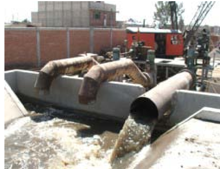
Cárcamo ubicado en Av. Bordo de Xochiaca intersección con Av. Vicente Villada
