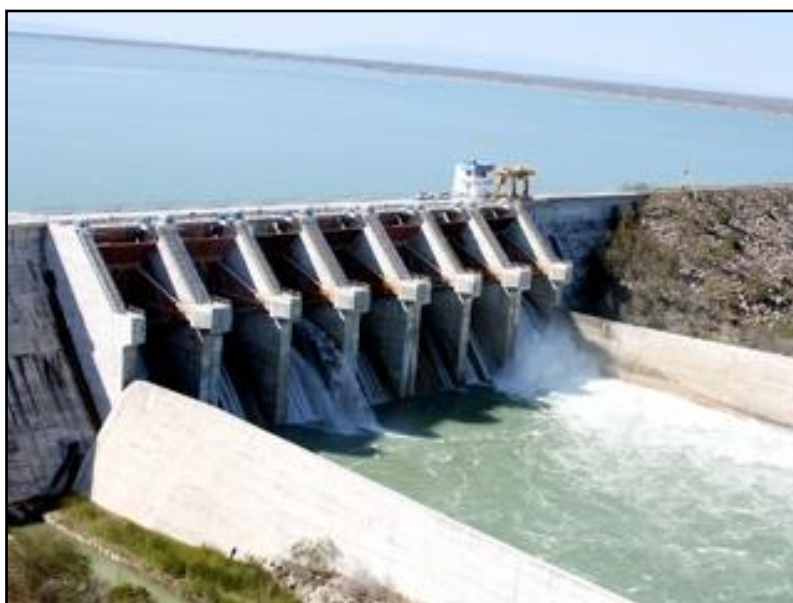
Figura II-6. Obra de Excedencias presa El Cuchillo
