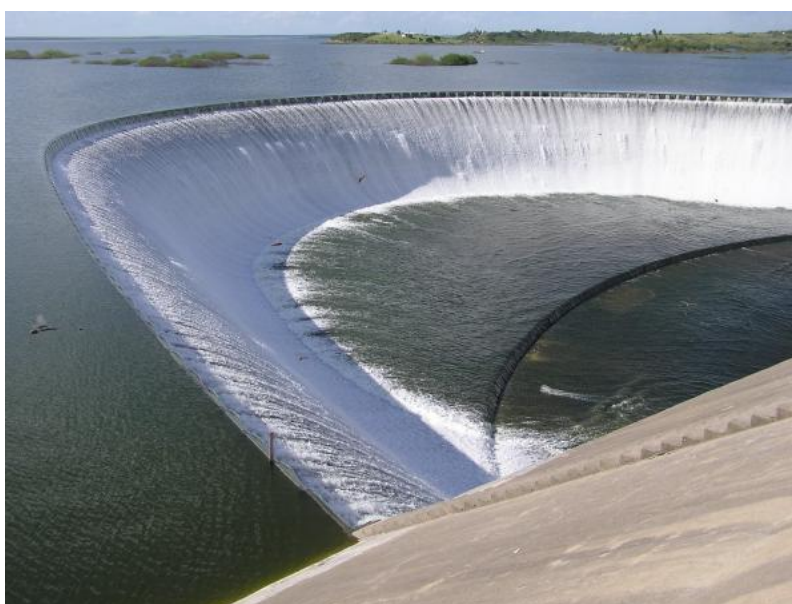
Figura II-3. Obra de excedencias presa Marte R. Gómez
