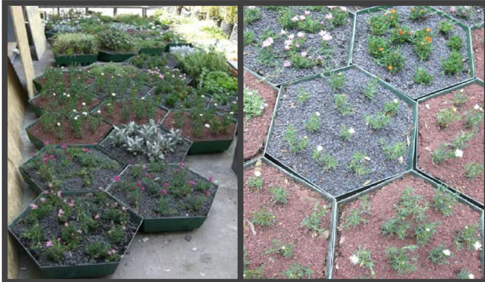
Imagen 21.- Muestra de la unión de los módulos para losas de azotea
