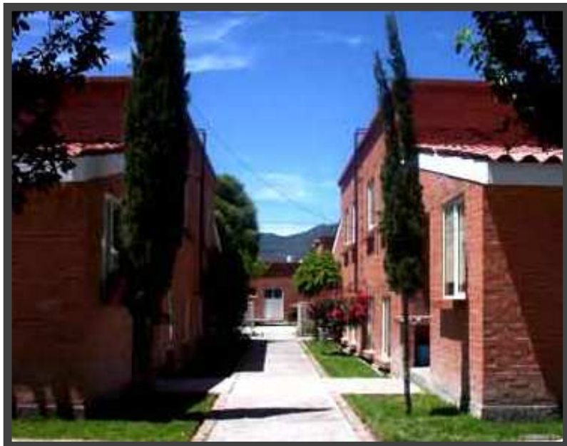
Imagen 8.- Vista pasillo de acceso a los módulos habitacionales
