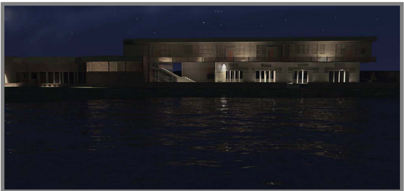
Imagen 92.- Vista nocturna de la fachada posterior en donde se aprecia la iluminación del edificio.
