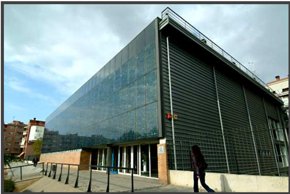
Imagen 15.- Paneles solares en fachada de la Biblioteca Pompeu Fabra de Mataró
