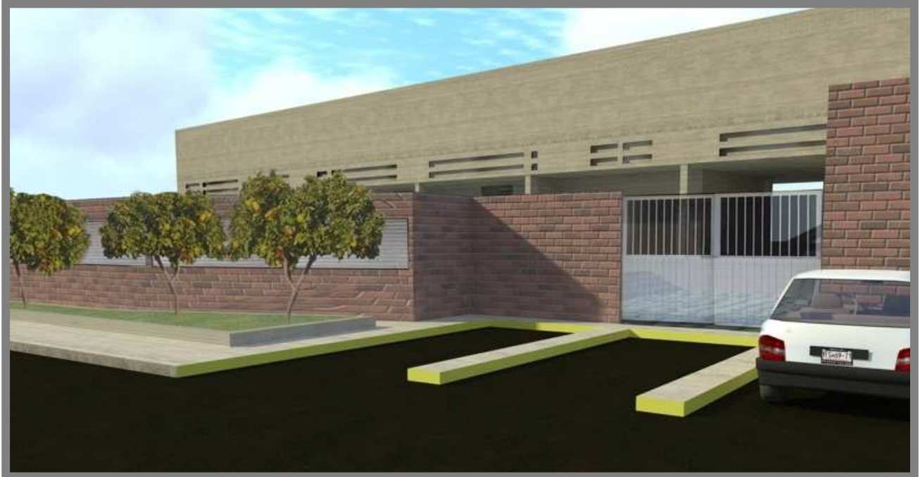
Imagen 93.- Área de estacionamiento
