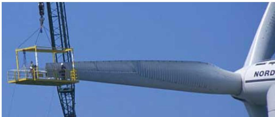
Pala de 32 m. de un Aerogenerador de 1.5 MW
