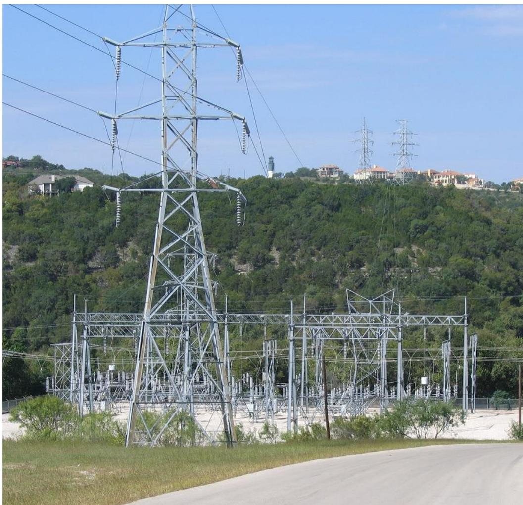
Fotografía de una Subestación Eléctrica, es aquí donde se incrementa el voltaje para su transmisión a grandes distancia.
