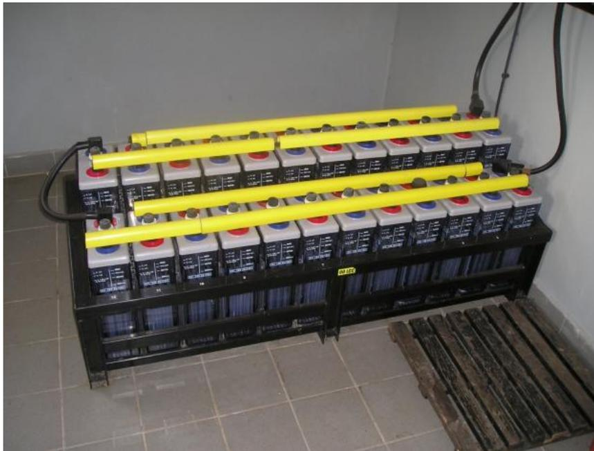
Fotografía de un banco de baterías, aquí se almacena la energía obtenida de un generador Eólico
