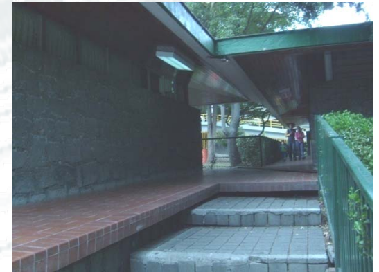
Circulaciones a Cubierto
