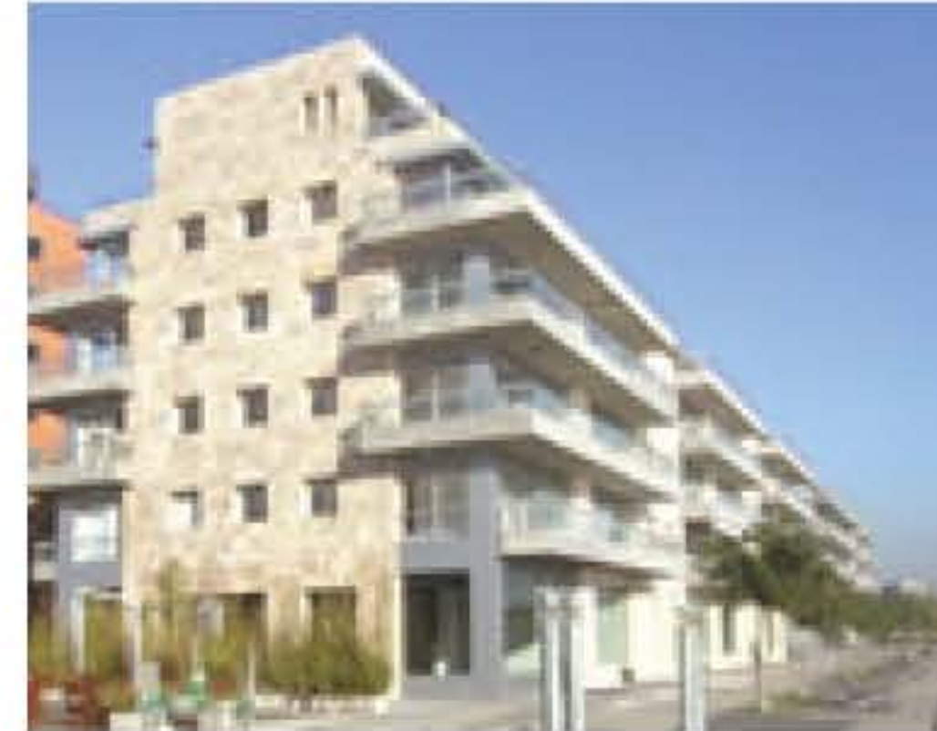
Edificios Cruceros I y II
