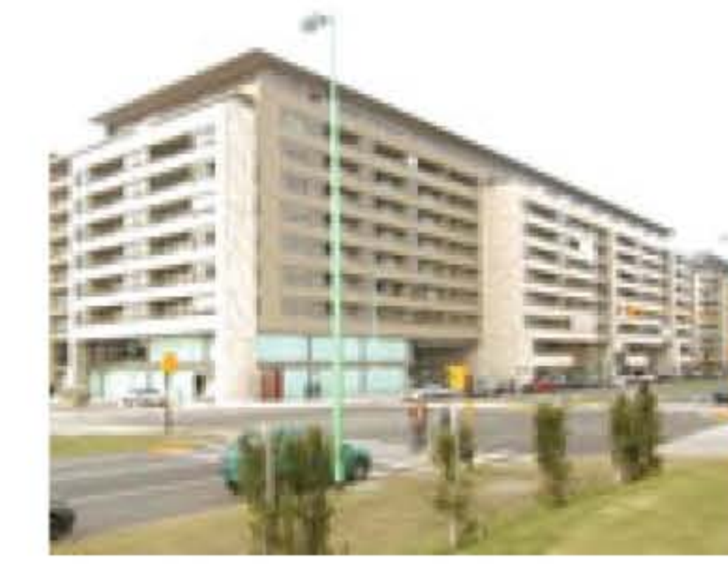
Edificios Madero Plaza
