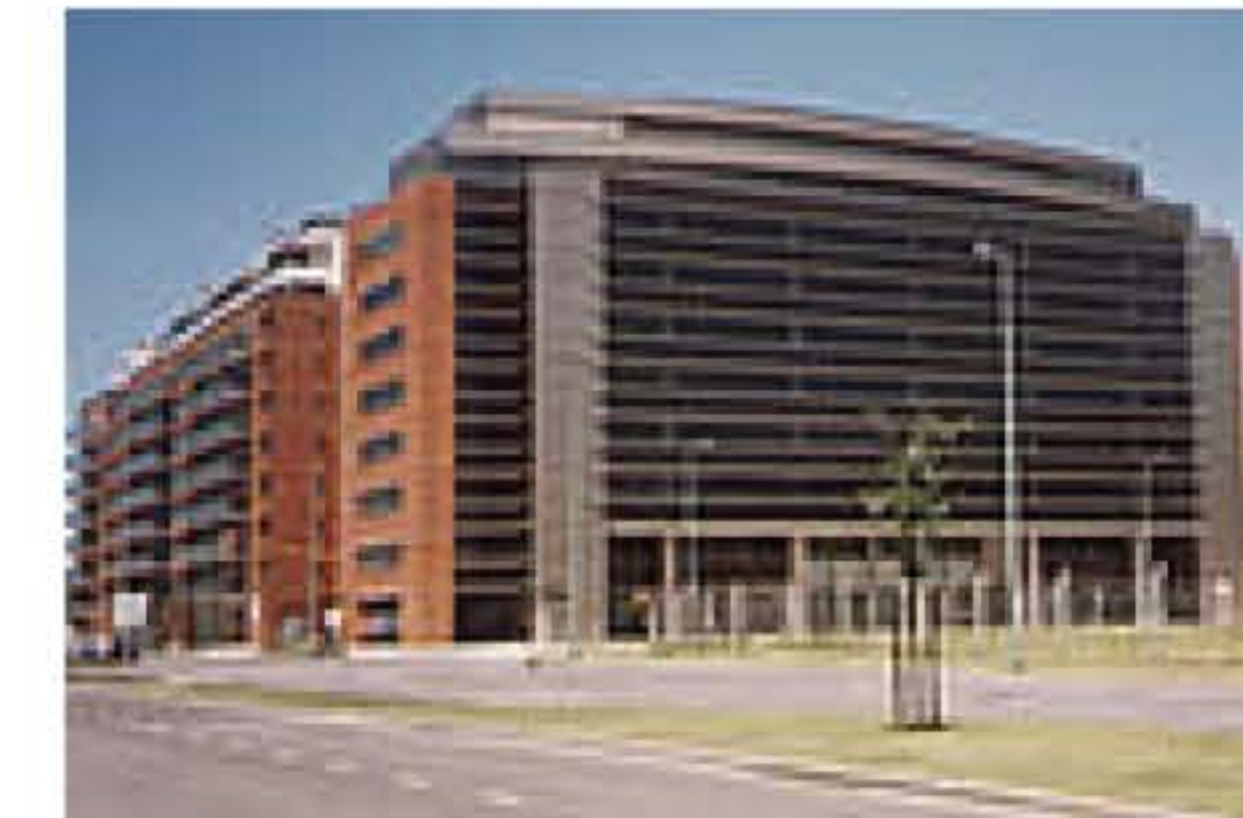
Edificio Brisas Office
