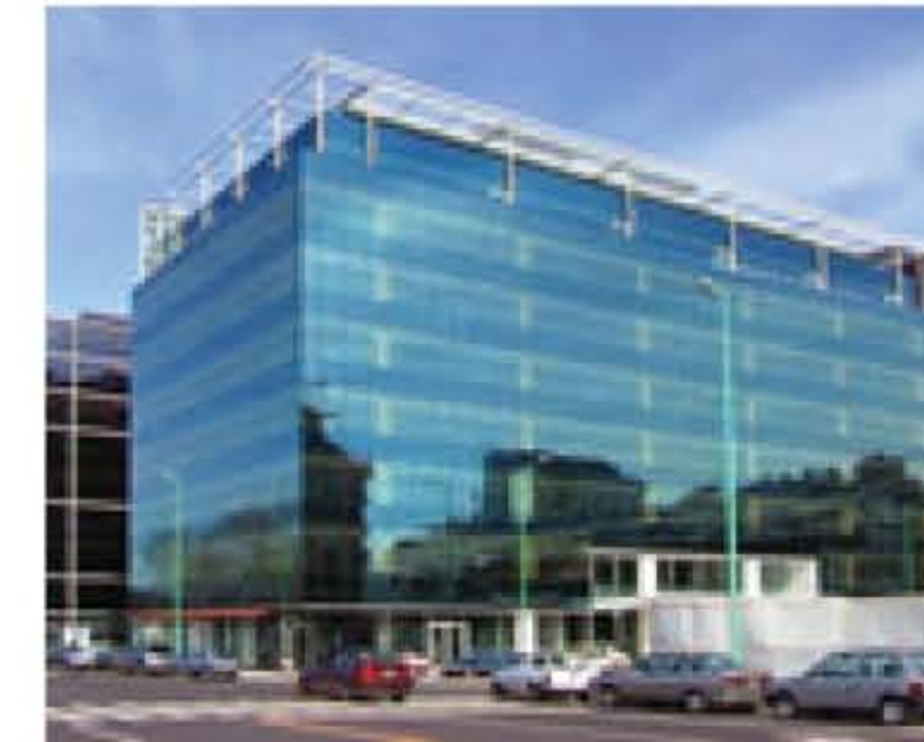
Edificios Colonos Plaza
