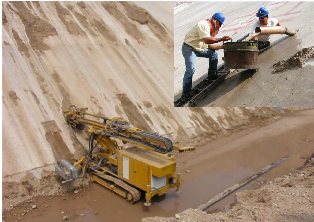
Figura IV.9 Barrenos de drenaje en la losa L-22.
