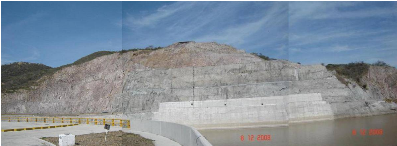
Figura V.3 Tratamientos en el talud derecho del canal de llamada de la obra de excedencias
