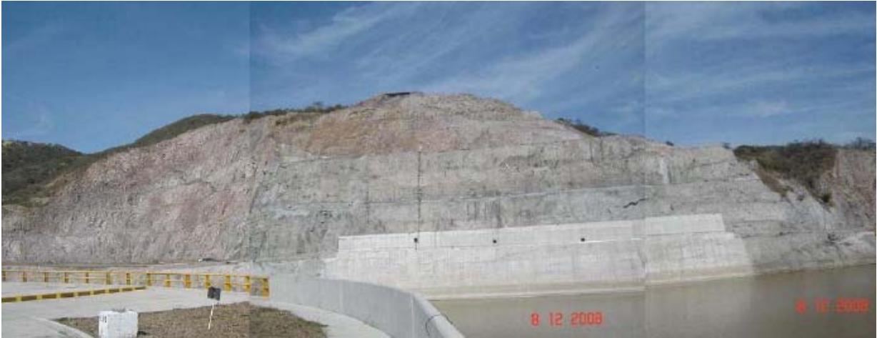
Figura IV.23 Talud derecho del canal de llamada de la obra de excedencias.
