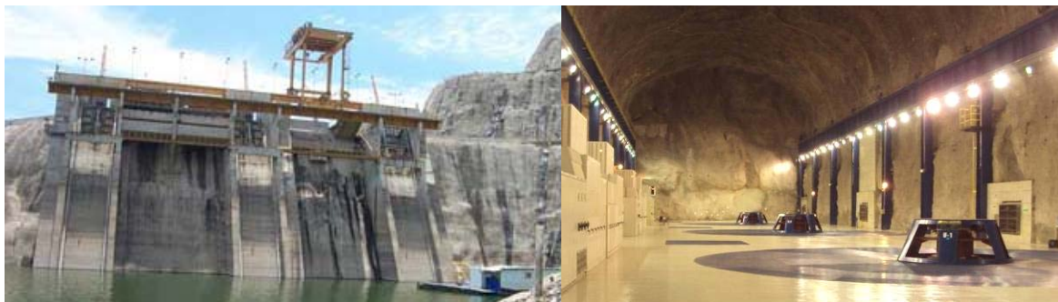
Figura II.7. Obra de toma y casa de máquinas.
