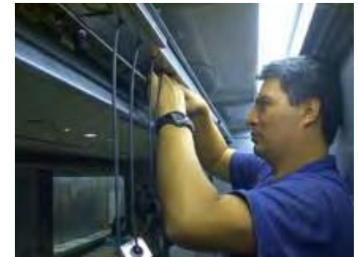
Imagen 8. Montaje de iluminación.
