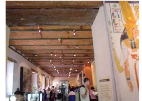
Imagen 28. Vigueta y bóveda catalana.
