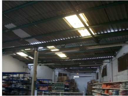
Figura 26: Techo de lámina en almacén.
