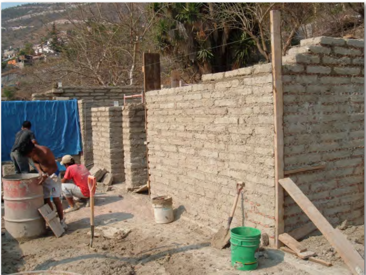
Figura 2|24. Vista del muro desde el interior de la casa.
