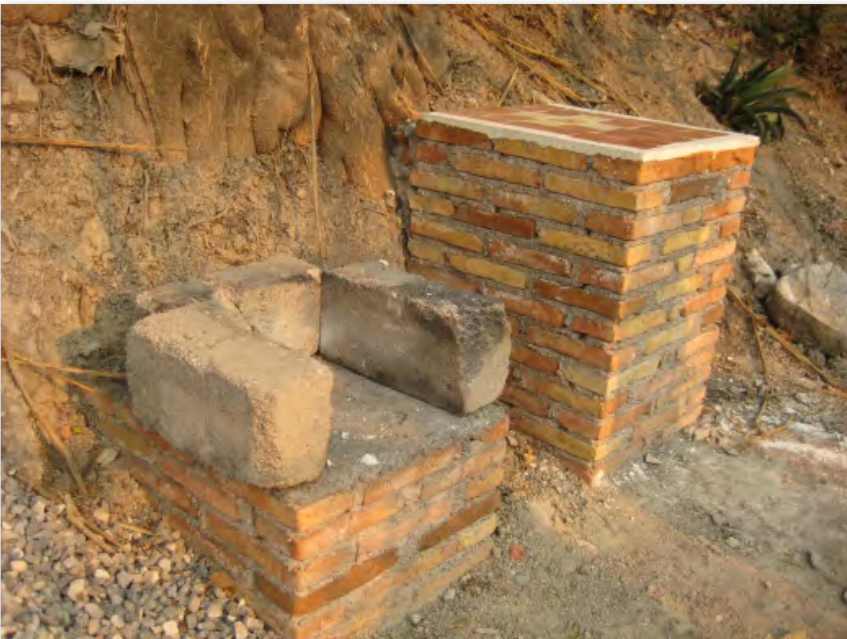
Figura 3|35. Tlecuile (fogón para ollas y comales) y mesa de tabi- que y azulejo. Ubicados al fondo de la cochera.
