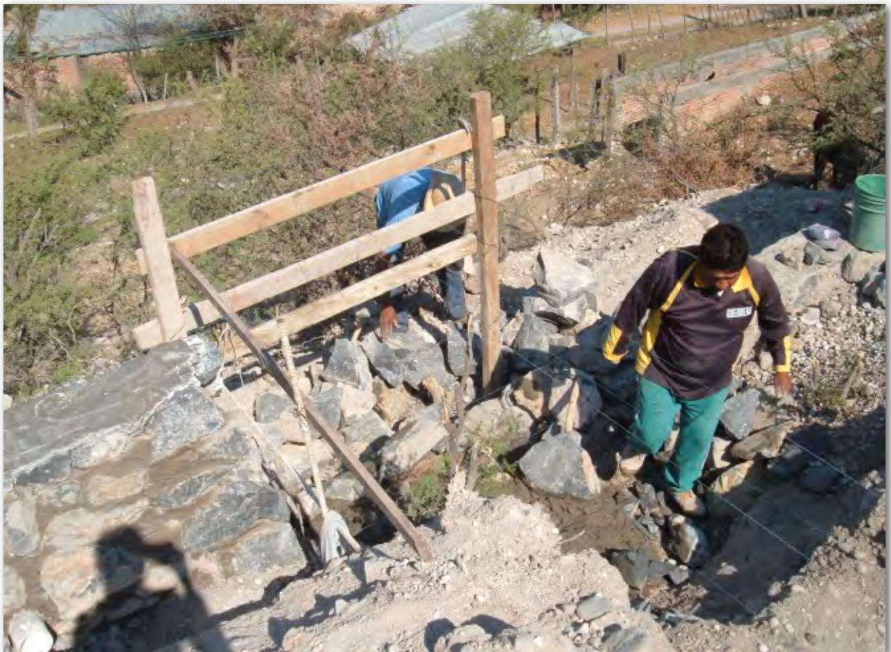
Figura 2|10. Mampostería juntada con mortero.
