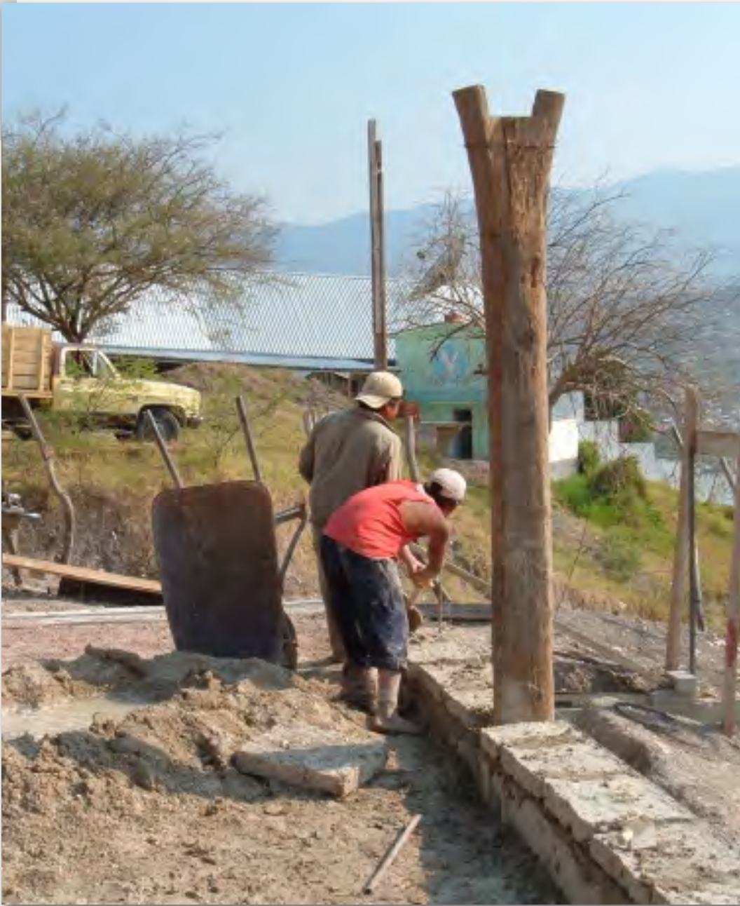
Figura 2|31. Poste con horqueta, ahogado en el muro de contención.
