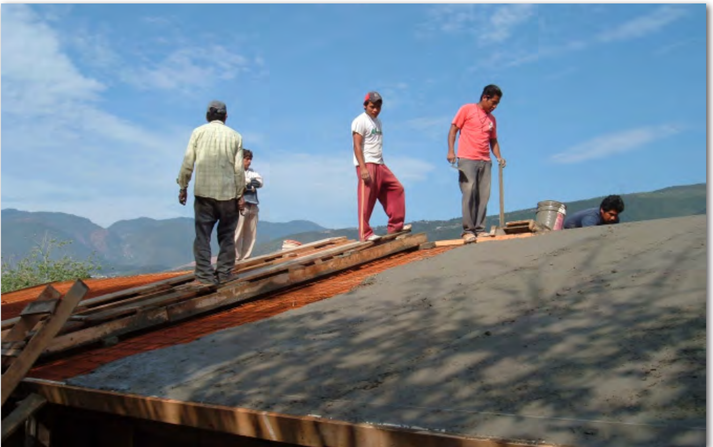
Figura 2|50. Colocado de losa inclinada.
