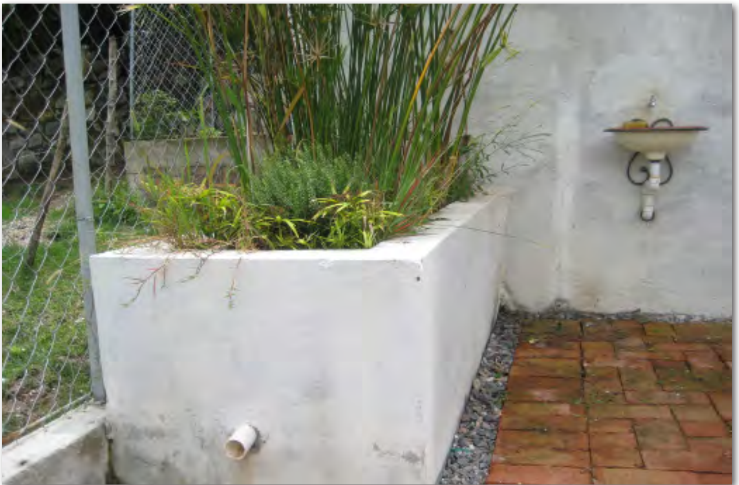
Figura 3|08. Jardine- ra para desfogue de aguas jabonosas.
