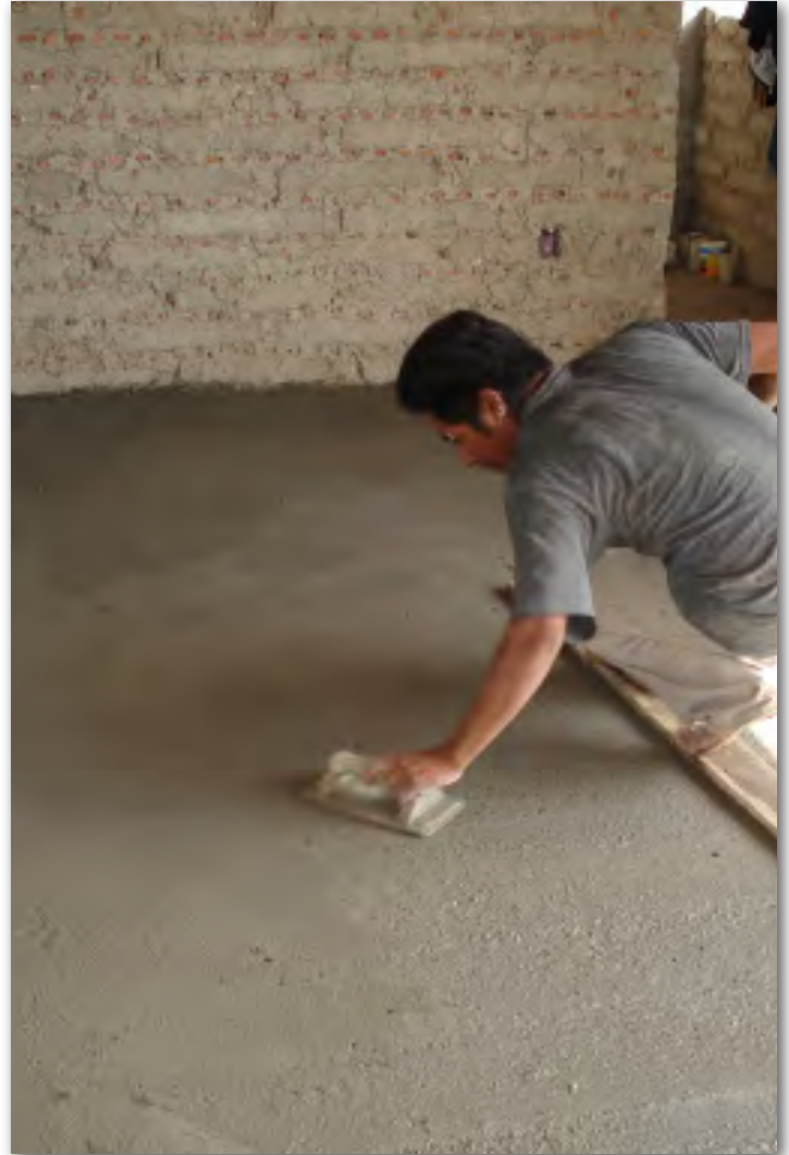
Figura 3|15. Aplanado de piso
