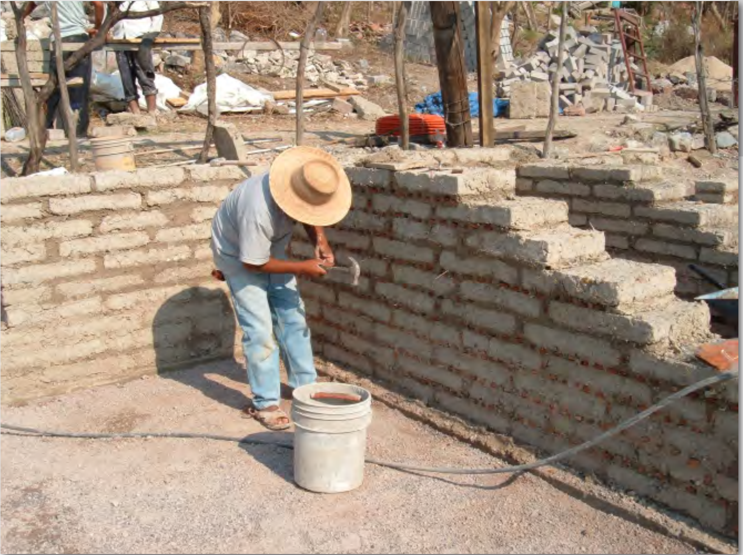
Figura 2|27. Colocación de piezas de adobe en el muro.
