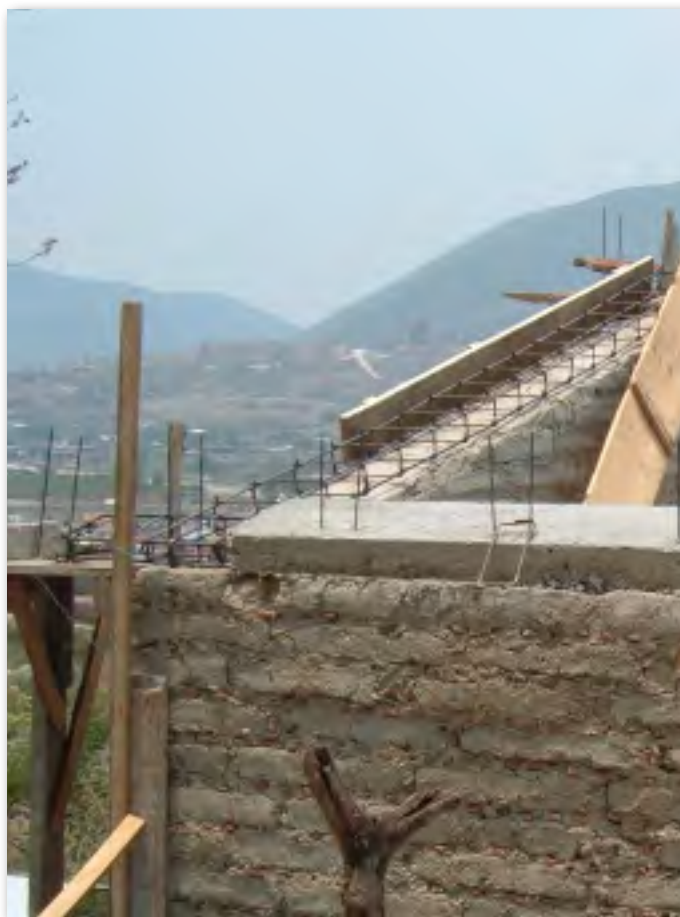
Figura 2|38. Dala longitudinal colada. Dala diagonal cimbrándose.
