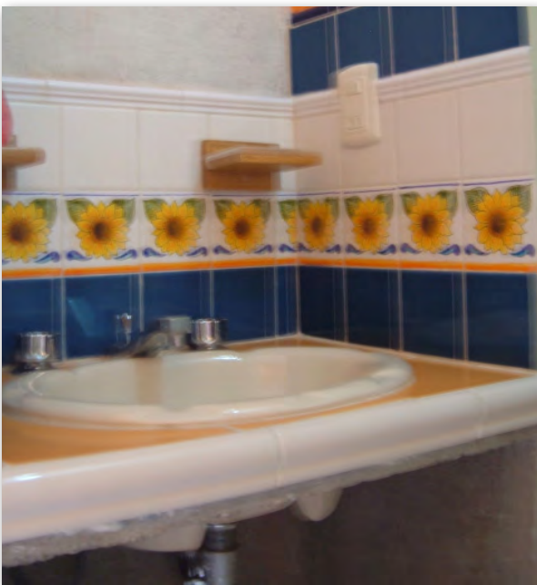
Figura 3|06. Lavabo artesanal ya instalado y funcionando.
