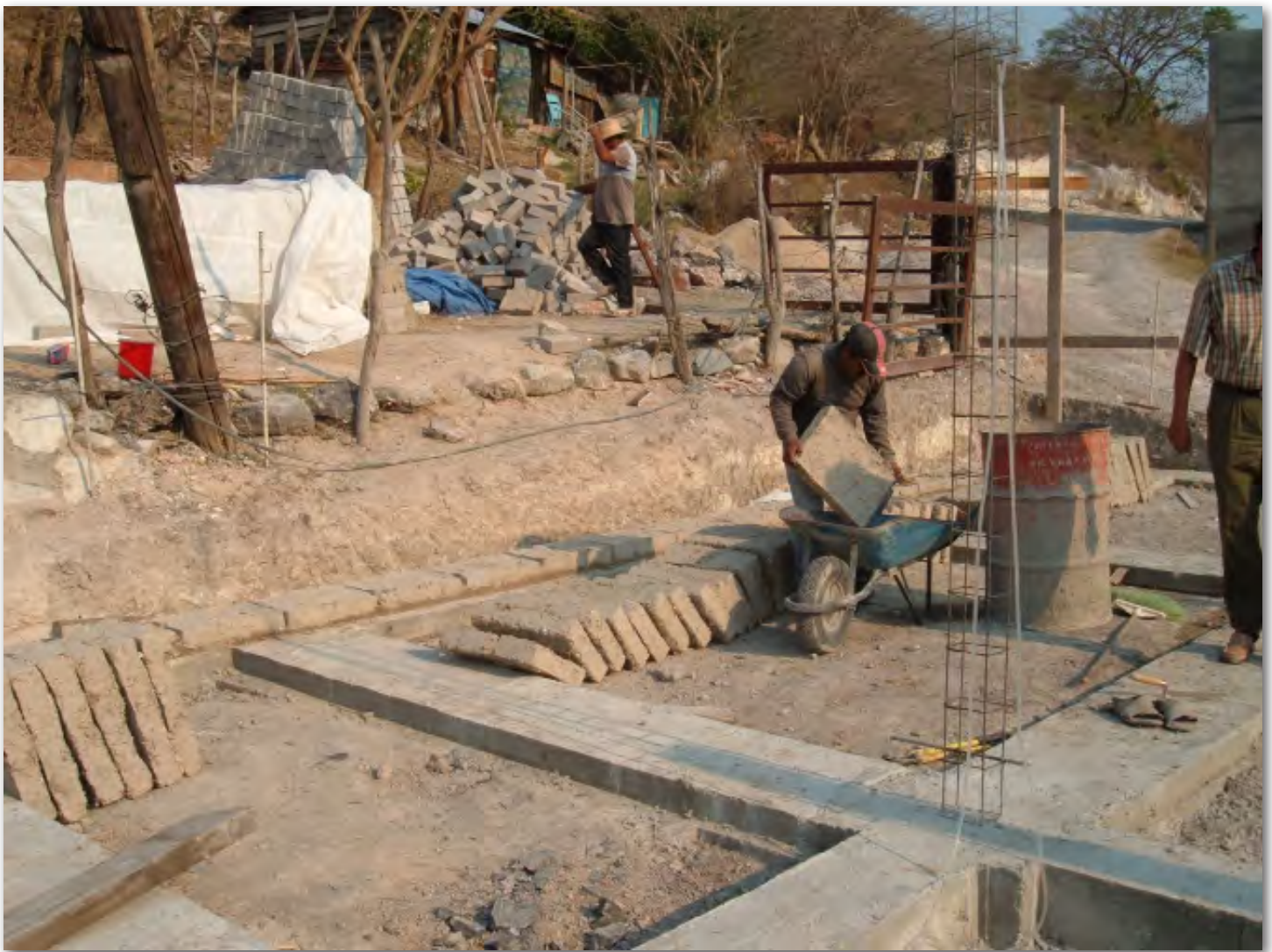
Figura 2|06. Vista del cruce de ejes que muestra la plancha de cimentación.
