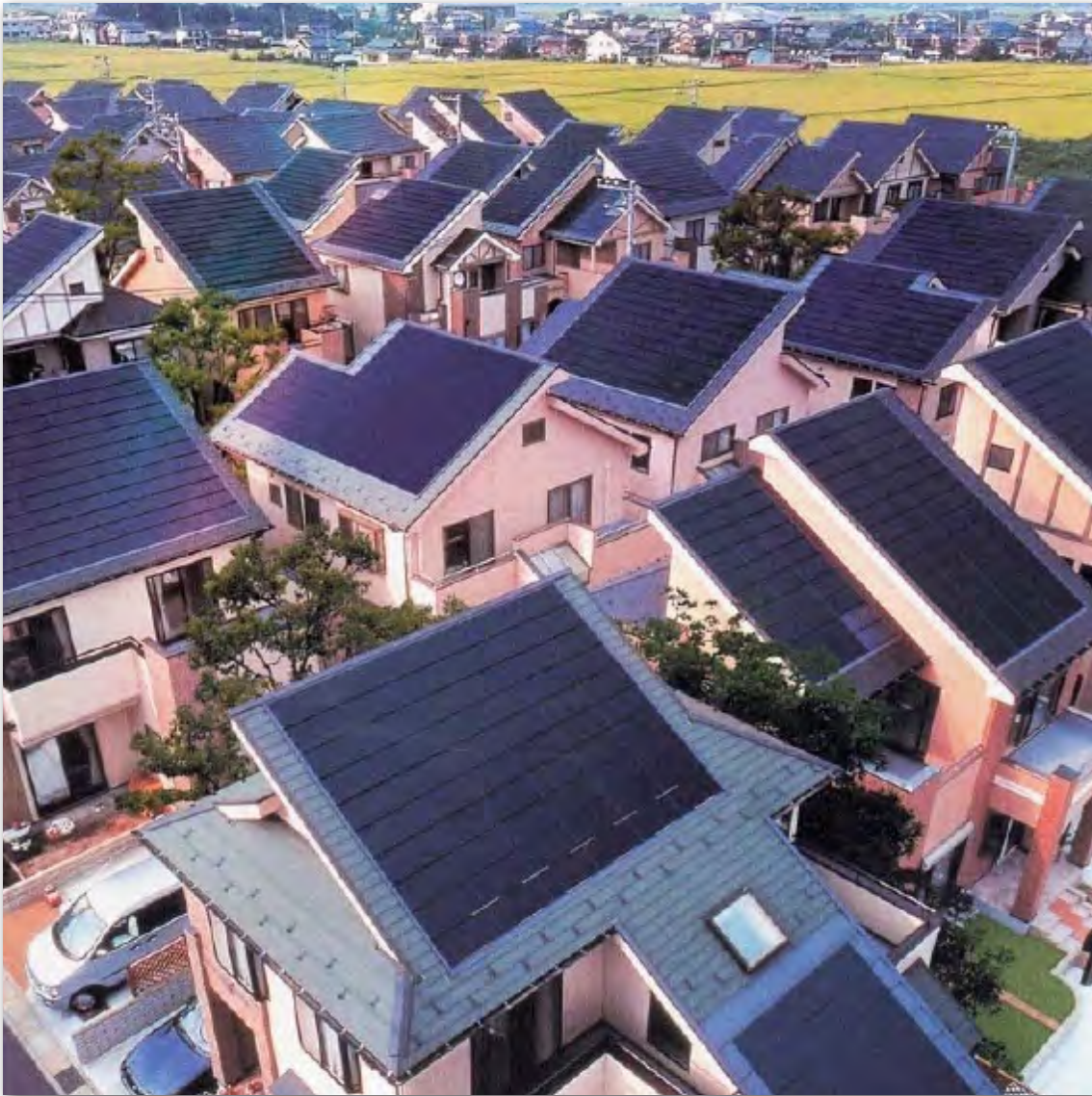
Figura 4|39. Conjunto residencial con paneles fotovoltaicos en Japón.
