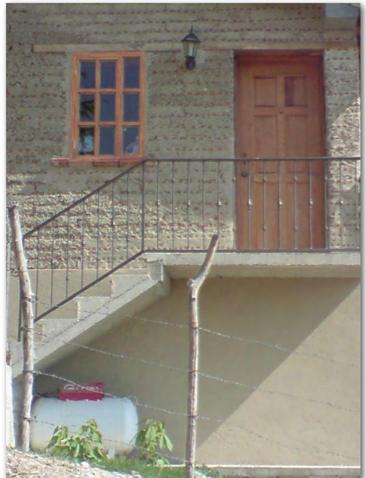
Figura 3|13. Tanque estacionario, escondido bajo escaleras de servicio
