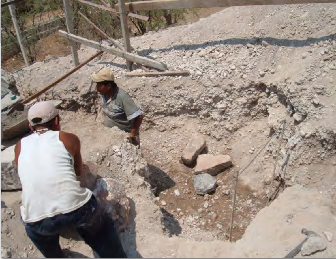
Figura 2|08. Cepa para la colocación de muro de contención.
