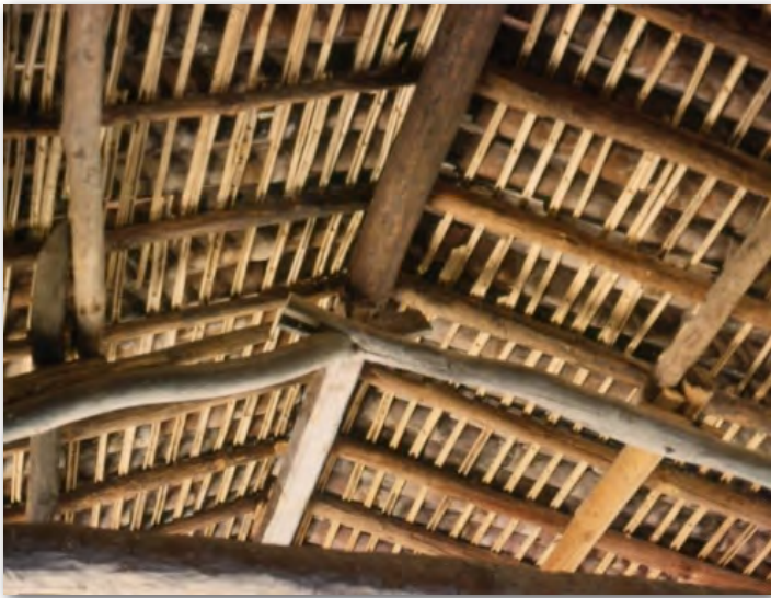
Figura 1|19. Estructura de Madera. Coahuayutla, mun. de Coahuayutla
