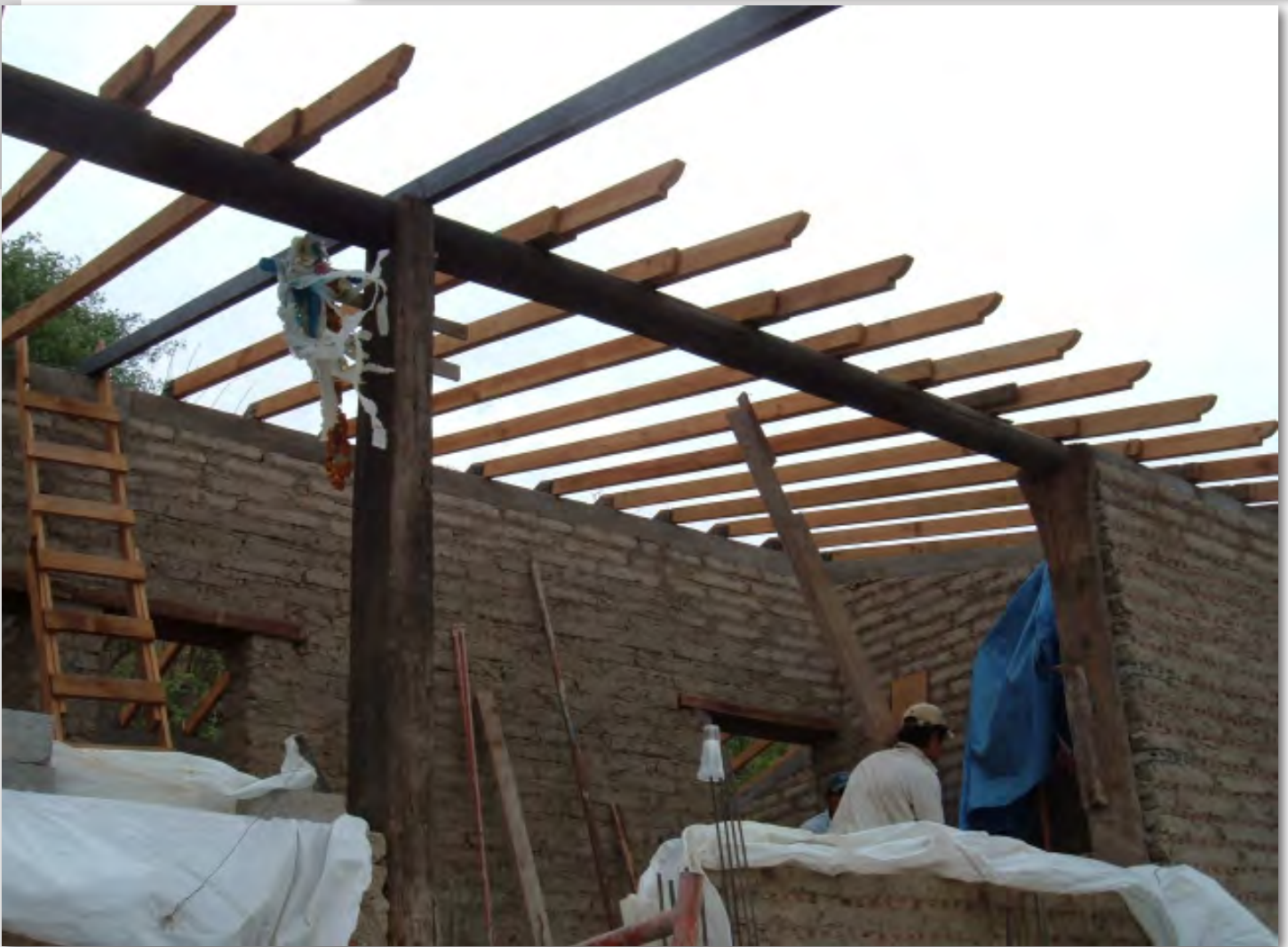
Figura 2|34. Viguetas descansando sobre viga de madera.
