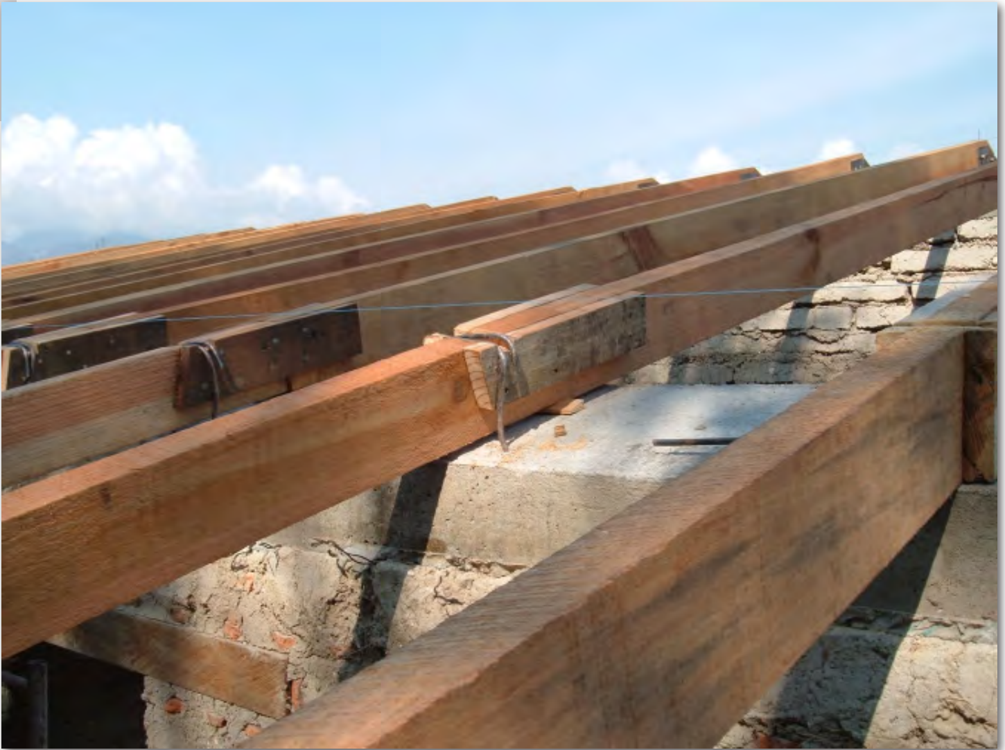
Figura 2|40. Viguetas sujetas con alambón a la dala y encachetadas con maderas.
