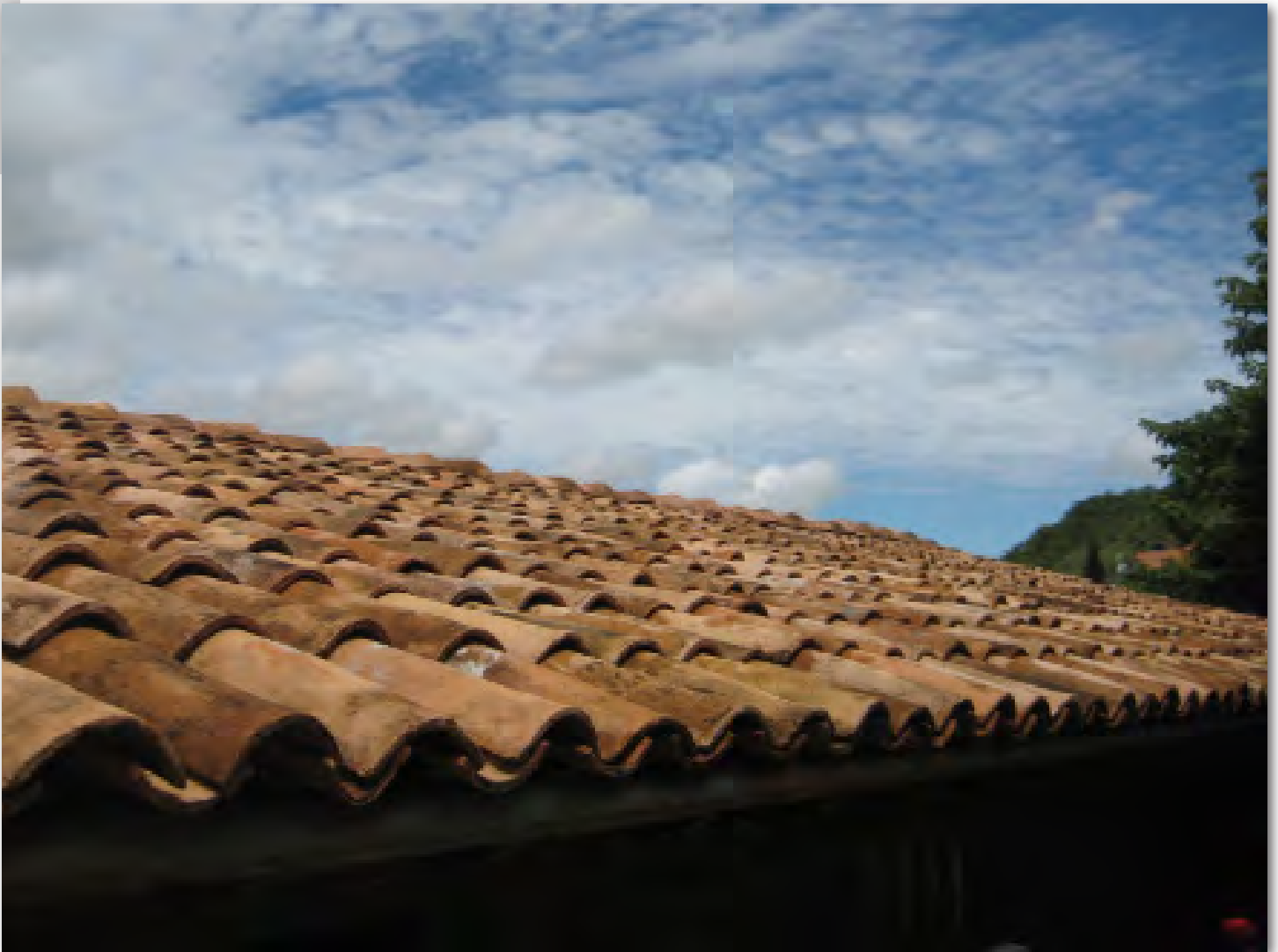
Figura 2|53. Teja sobre losa ya colocada.
