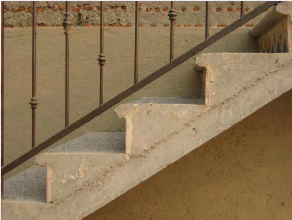
Figura 3|25. Perfil de escalera. Se puede apreciar la construcción de la rampa.
