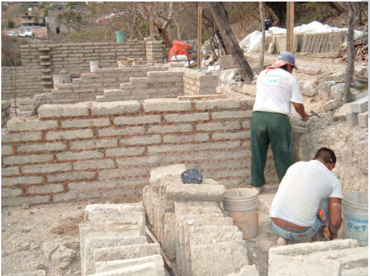
Figura 2|23. Colocación de piezas de adobe para formar el muro.
