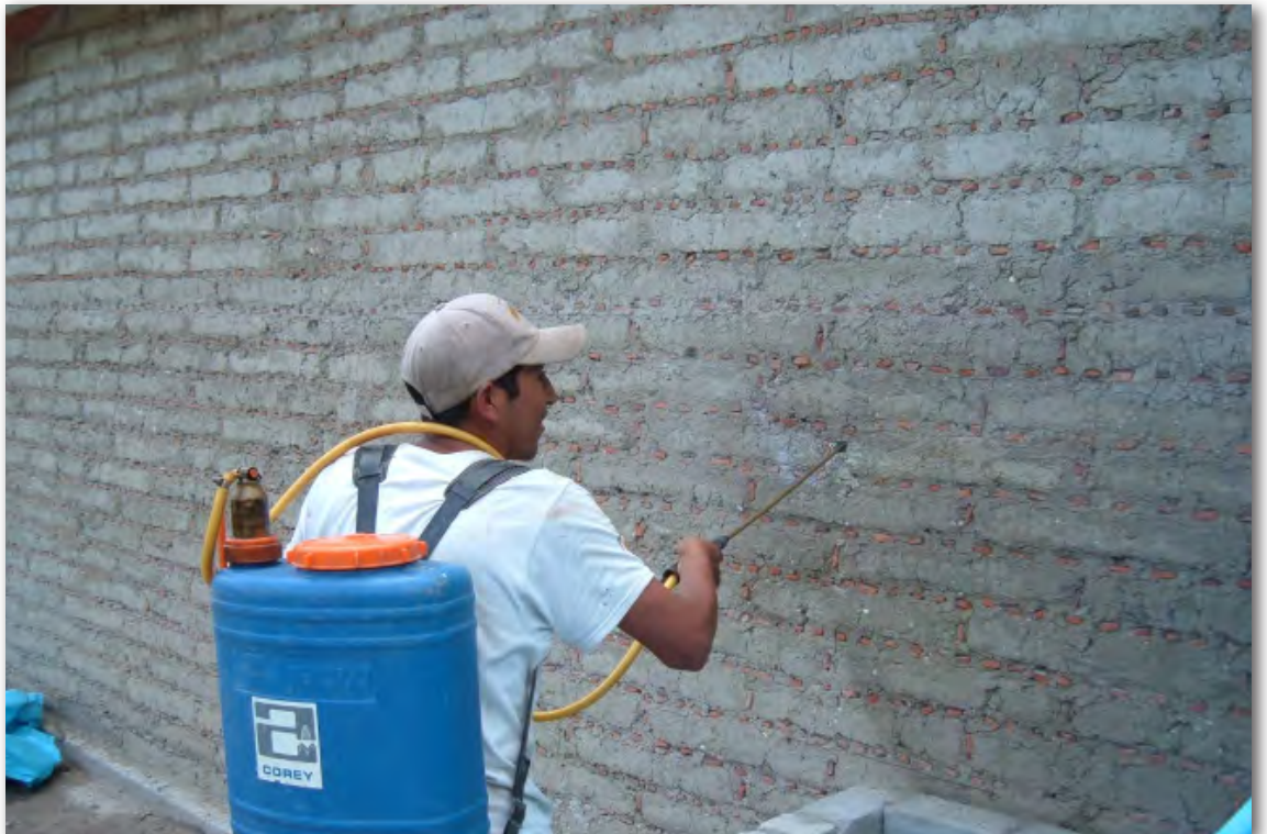
Figura 3|04. Se le agrega sellador vinílico a muros aparentes.
