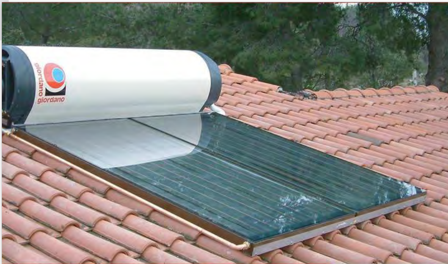
Figura 4|25. Calentador de agua con energía solar, en tejado tradicional.
