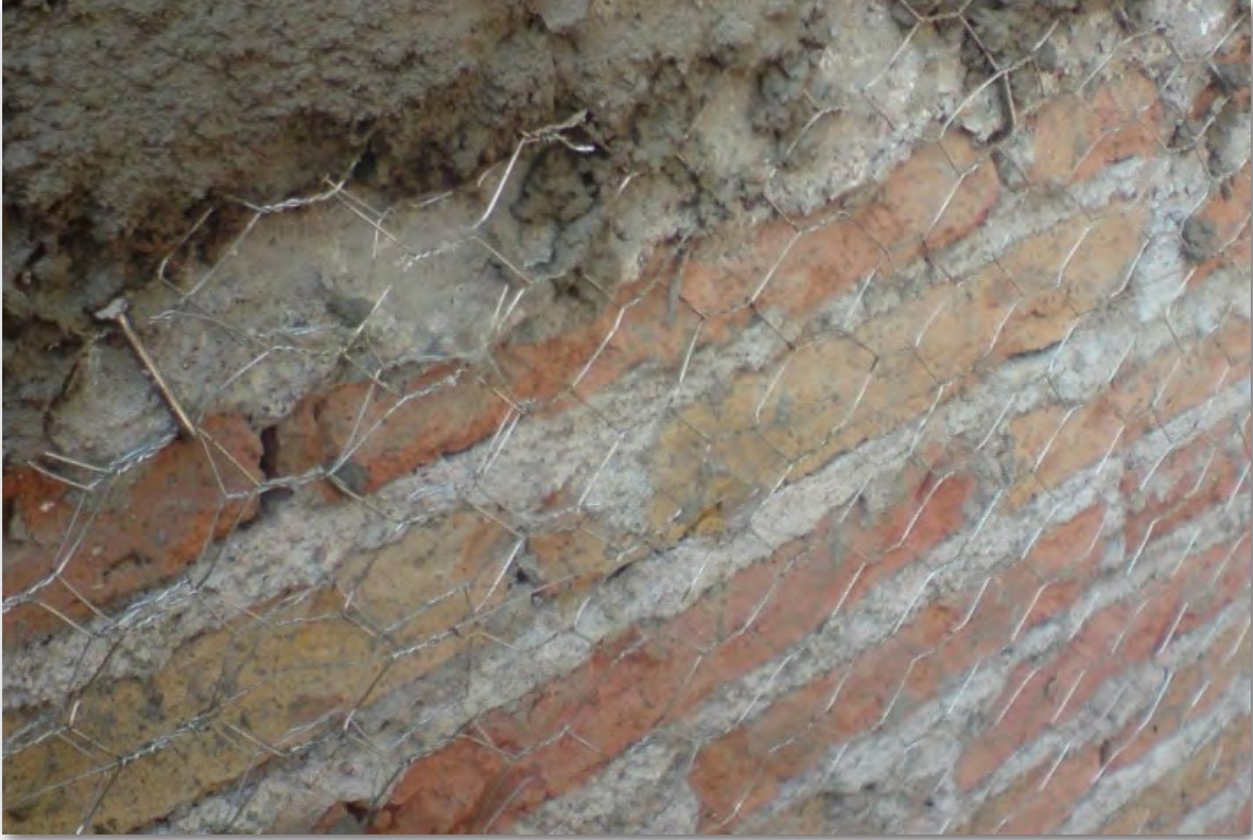
Figura 3|01. Malla de gallinero en muro de tabique. Proceso similar al muro de adobe.
