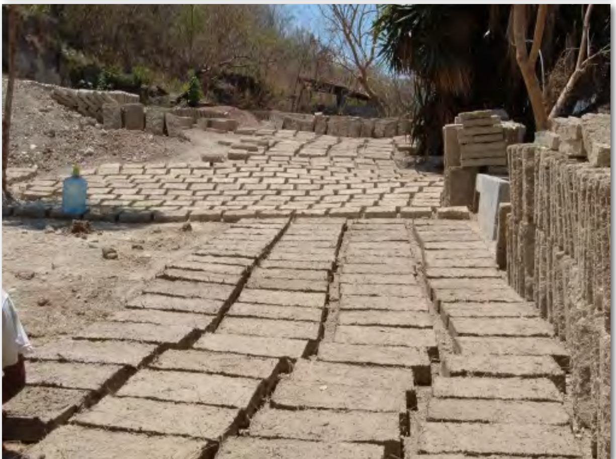
Figura 2|21. Piezas de adobe secas y apiladas.
