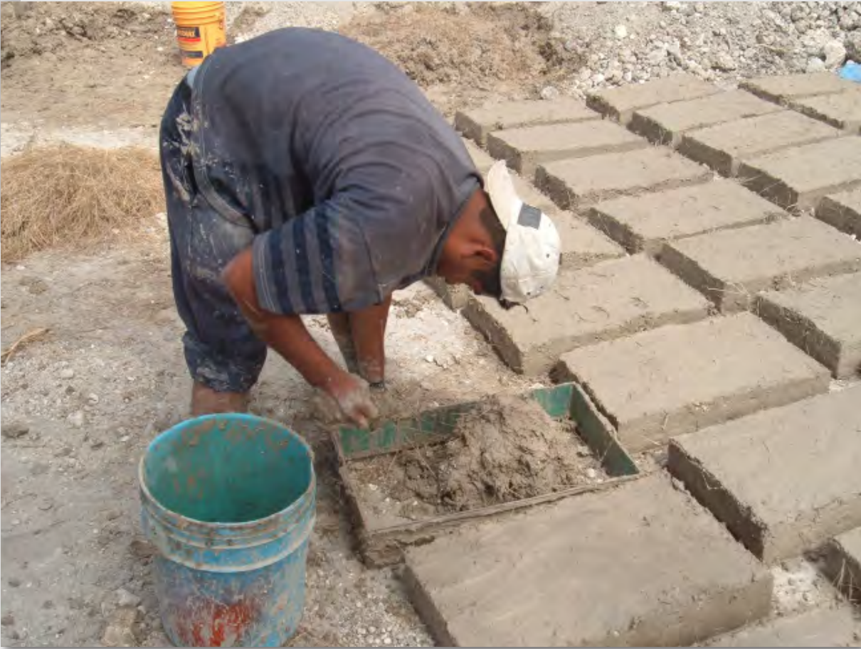
Figura 2|14. Colocación del barro en el molde.
