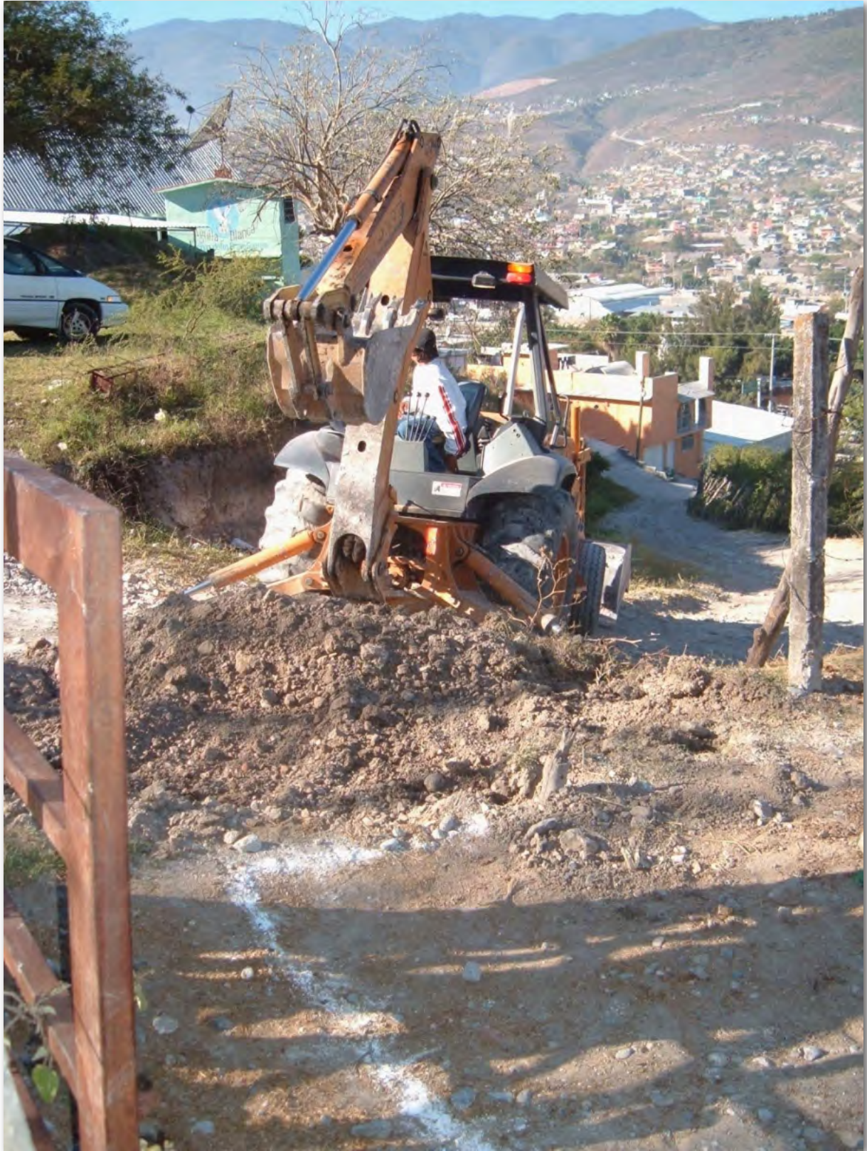
Figura 2|05. Trazo de ejes. Maquinaria para nivelación de terreno.
