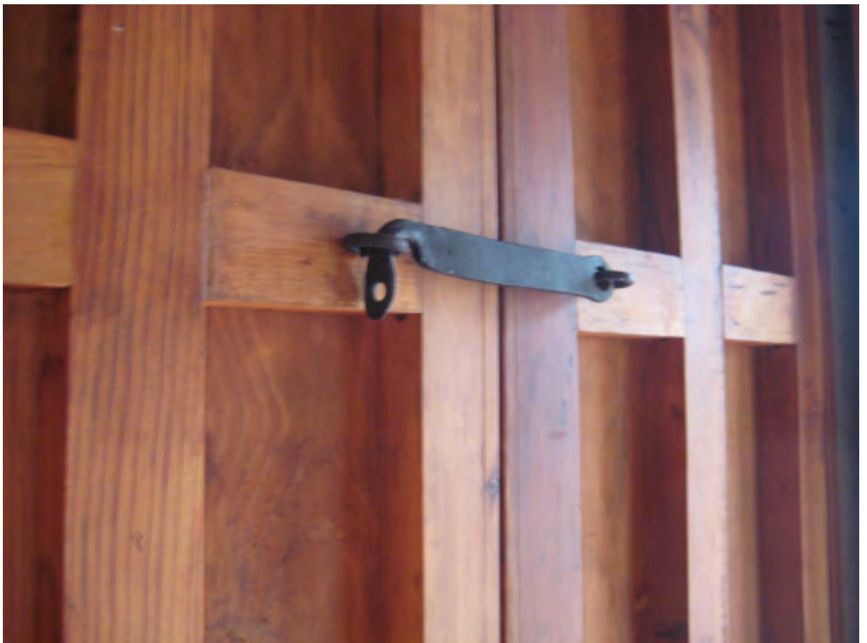
Figura 3|21. Aldaba de fierro, como seguro de ventana ciega
