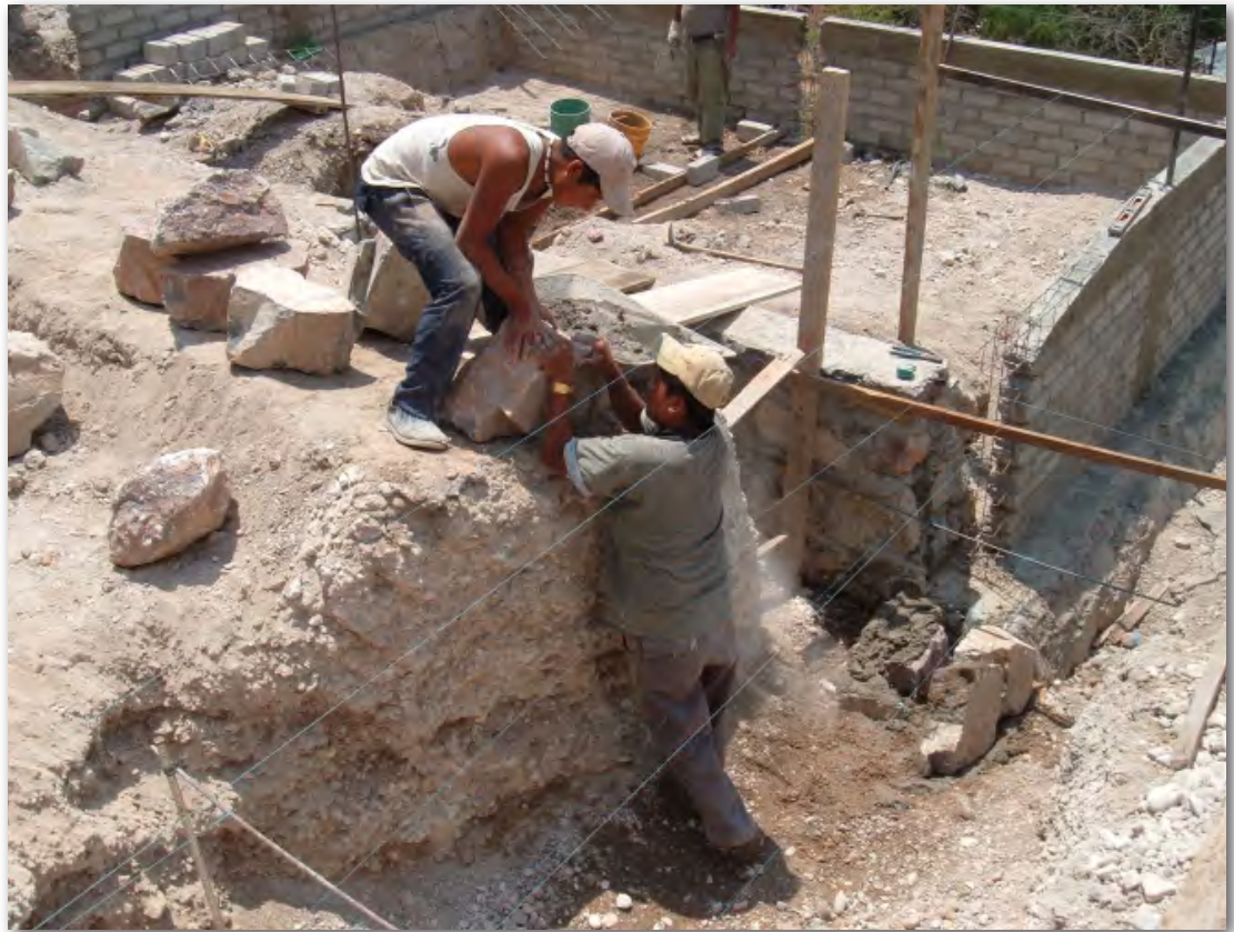
Figura 2|09. Transporte de piedra para mampostería.
