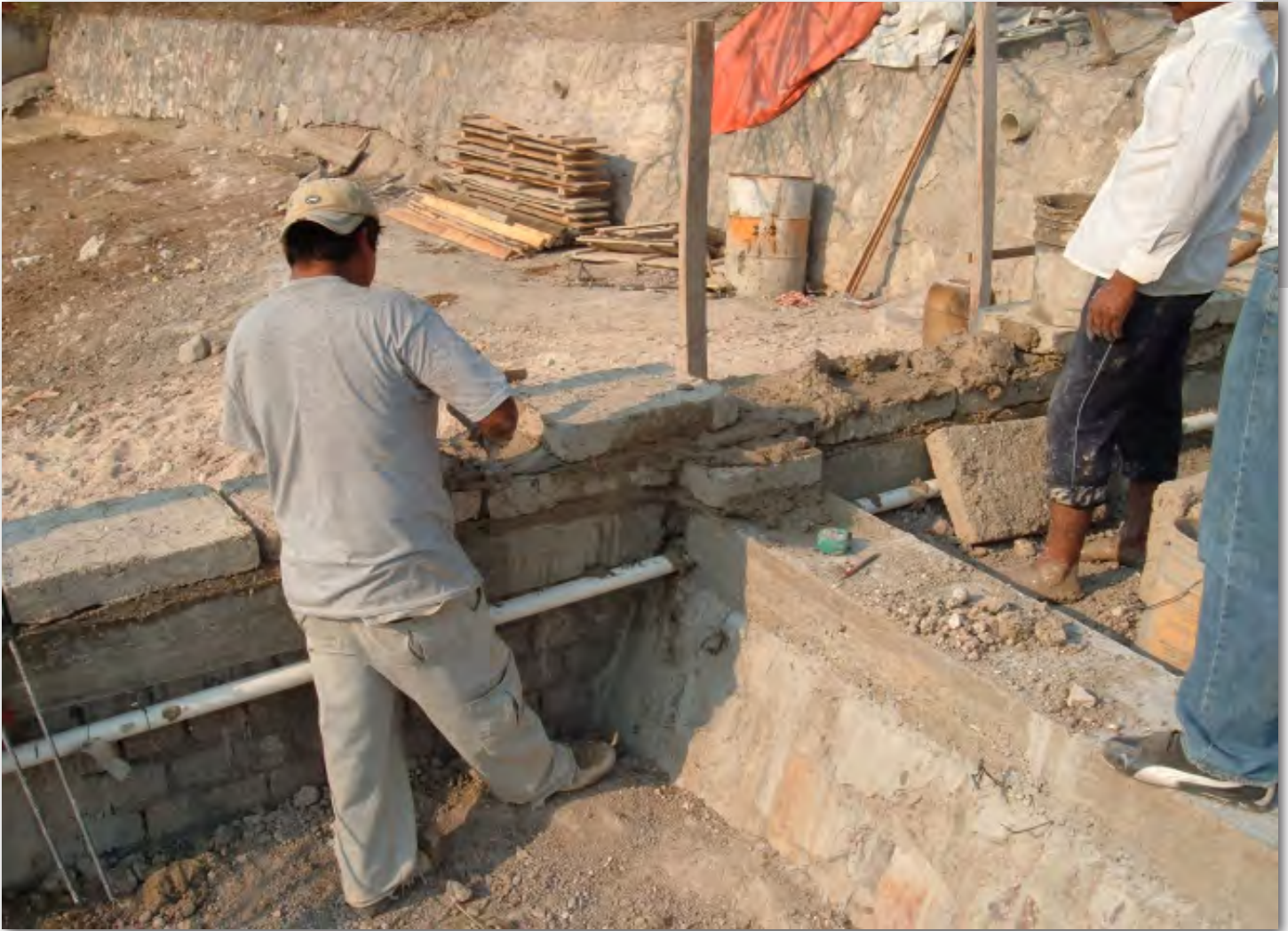
Figura 2|07. Muro de contención, plancha de cimentación y colocación de adobe.
