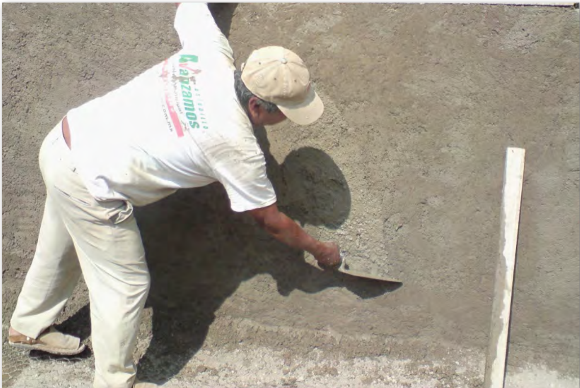
Figura 3|02. Aplanado de muro.
