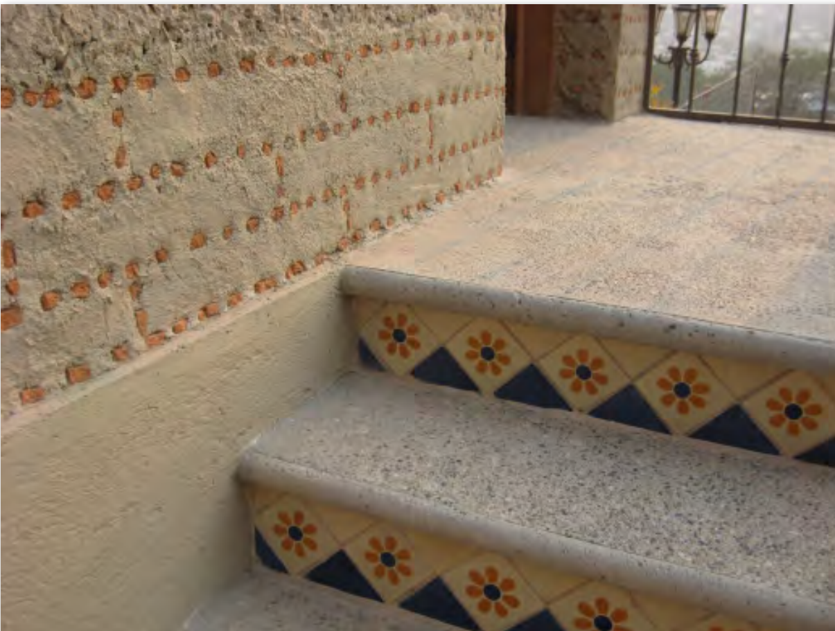
Figura 3|27. Particular de escalera.
