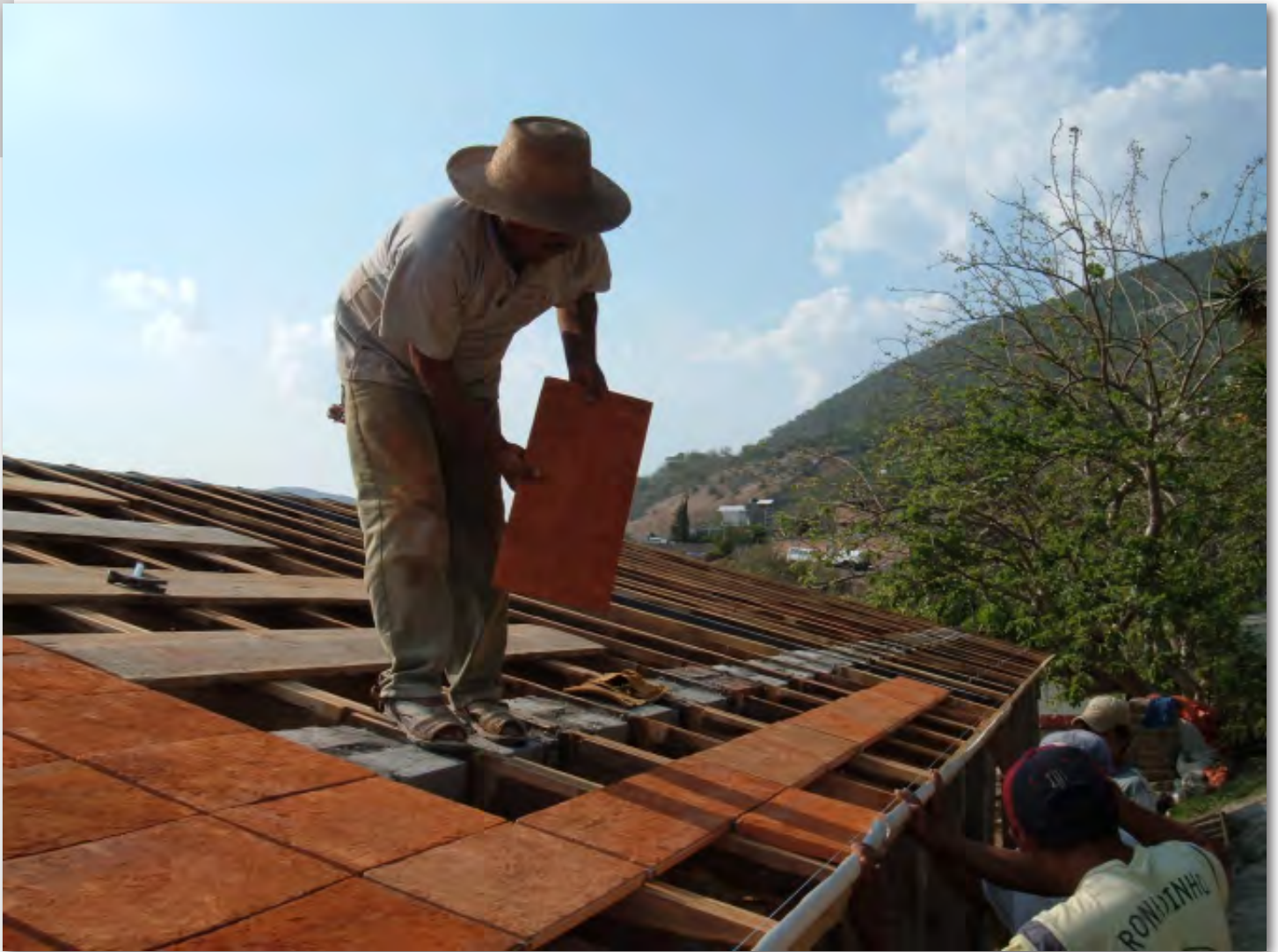
Figura 2|47. Colocación de solera sobre viguetas.
