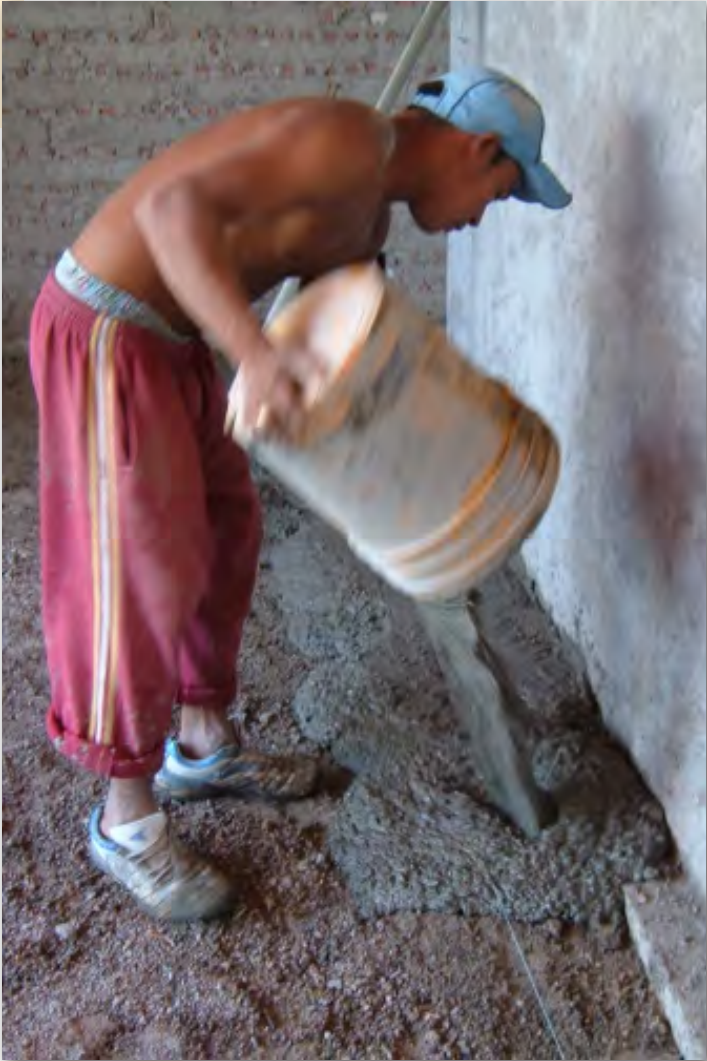
Figura 3|14. Construcción del firme hidráulico.
