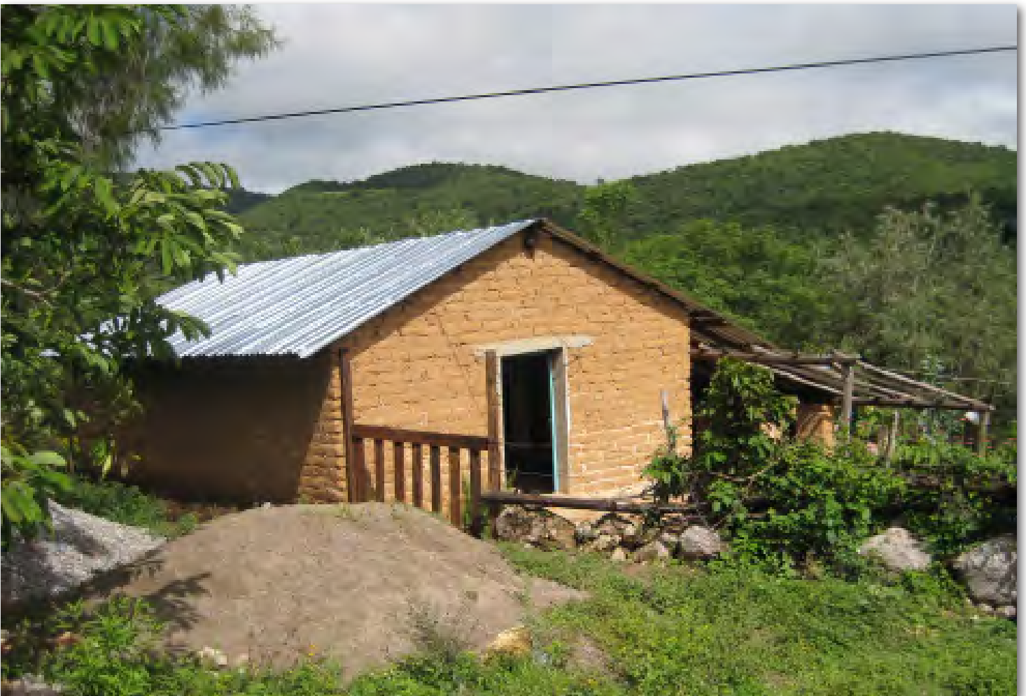
Figura 1|23. Uso de muro de Adobe y lámina galvanizada.
