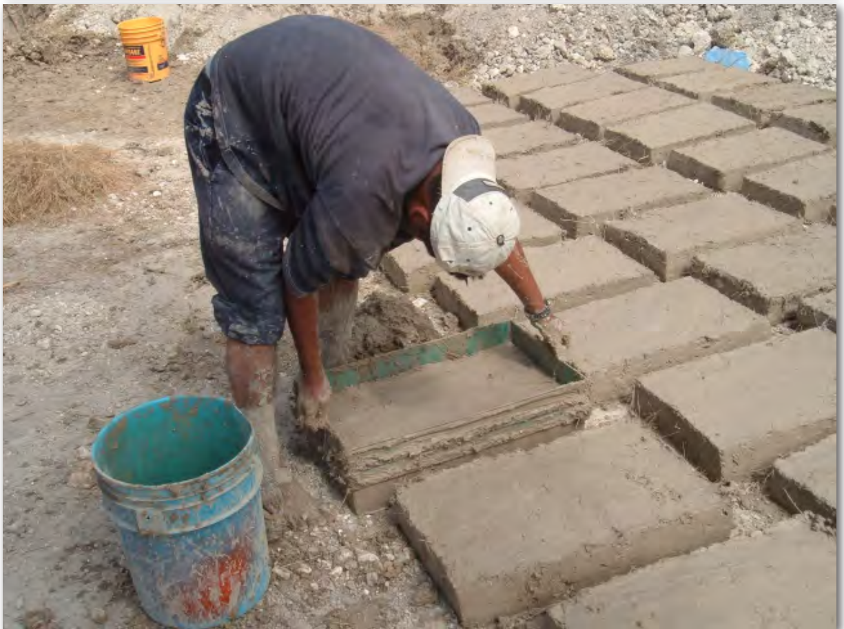
Figura 2|17. Retiro del molde.
