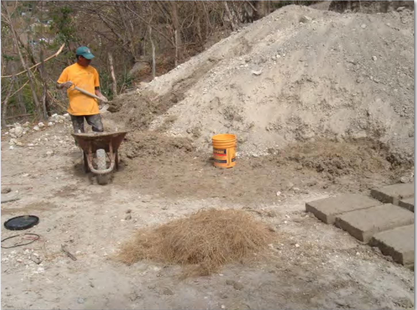
Figura 2|11 Extracción de arena apta para adobe. Zacate.
