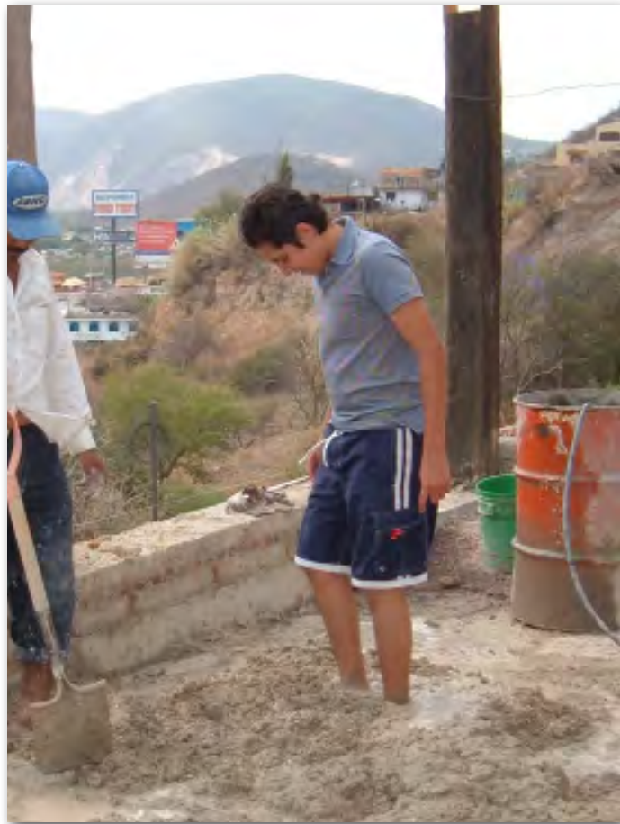
Figura 2|12. Amasado de barro para junteo.
