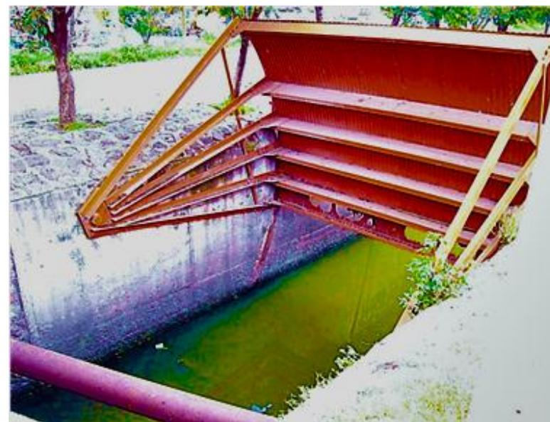
Canal de aguas residuales hacia laguna de oxidación y dispositivo regulador en mal estado.
