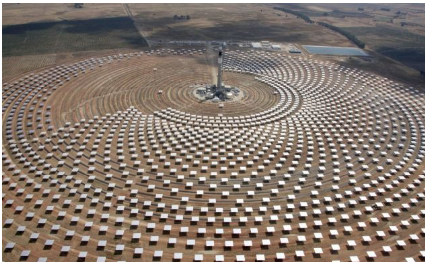
Fig. 1.9. Arreglo circular de planta solar. GEMASOLAR, Andalucía, España.
