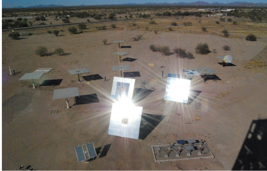
Fig. 1.14. Vista desde torre, el Campo de Pruebas de Heliostatos, Hermosillo, Sonora.
