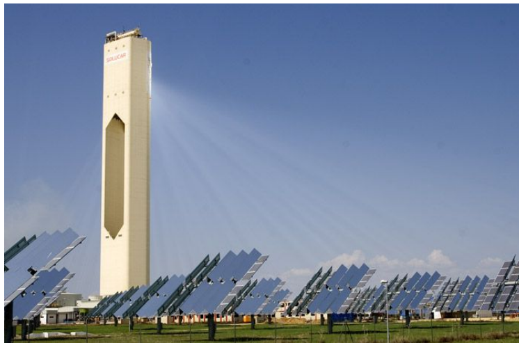
Fig. 1.7. Vista lateral de la planta comercial PS-10. Sevilla, España.
