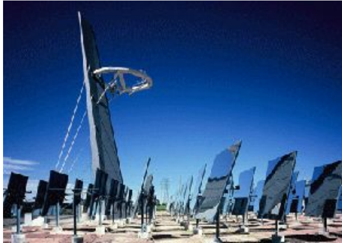
Fig. 1.10. Planta comercial CSIRO de helióstatos densamente instalados, Newcastle, Australia.
