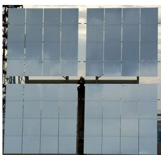
Fig. 1.13a. Helióstato con separación
