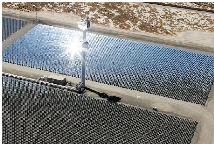
Fig. 1.11. eSolar, arreglo de subcampos norte-sur. Pasadena, California.
