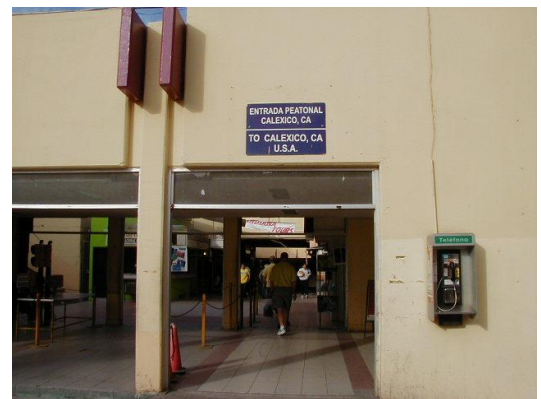
Imagen II.1.1.2. Paso peatonal Int. en Mexicali, B.C.N. (Fuente: Imágenes Google)
