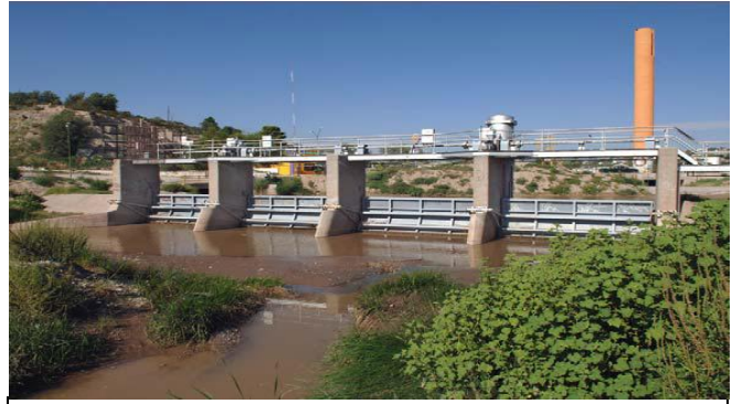
Imagen II.2.2.2. Presa derivadora Internacional y canal de la Acequia Madre. (Fuente: IBWC, 2006.)
