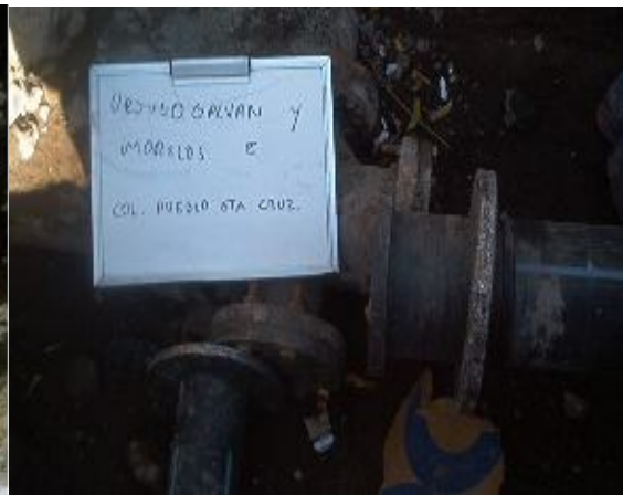
SECCIONAMIENTO EN CRUZ CON TAPA CIEGA (FOTOGRAFIA No 41)
