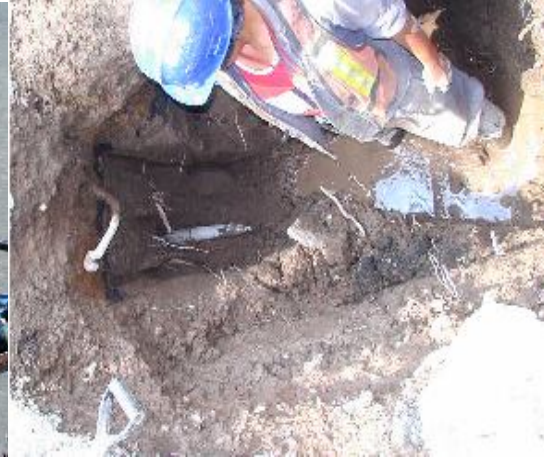
SALIDA DE "TOPO" (FOTOGRAFIA No 53)
