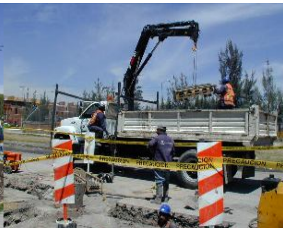
MANIOBRAS DE LA GRÚA EN OBRA (FOTOGRAFIA No 62)
