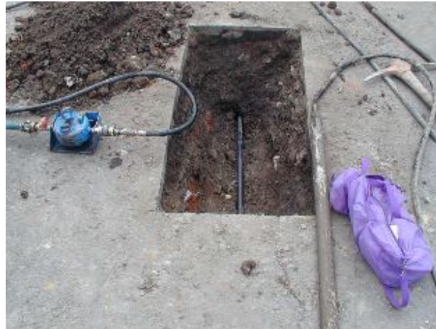
INTRODUCCIÓN DE TUBERÍA PARA RAMAL
