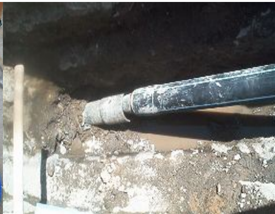
LANZAMIENTO DE TUBERÍA PEAD (FOTOGRAFIA No 50)
