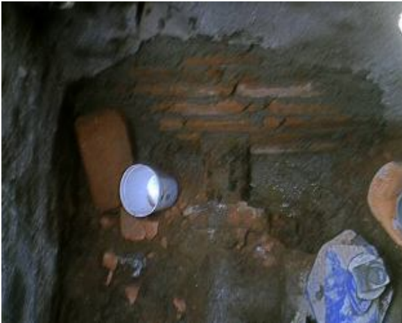
REPARACIÓN DE MURO (FOTOGRAFIA No 68)
