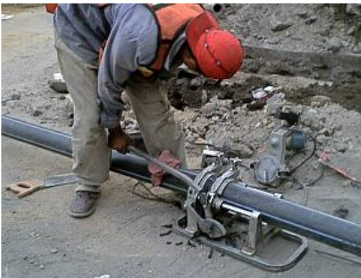
UNIÓN MANUAL DE TUBERÍA (FOTOGRAFIA No 33)
