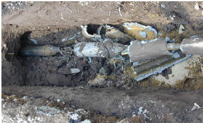
PROCESO DE REVENTAMIENTO Y SUSTITUCIÓN DE TUBERÍA
