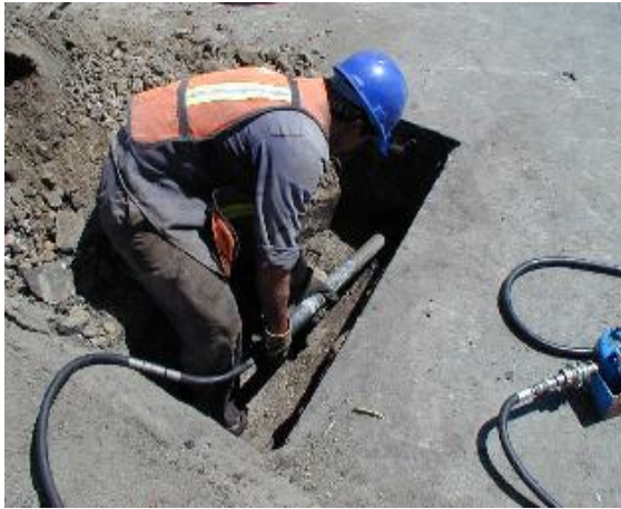
INTRODUCCIÓN DE "TOPO" (FOTOGRAFIA No 52)
