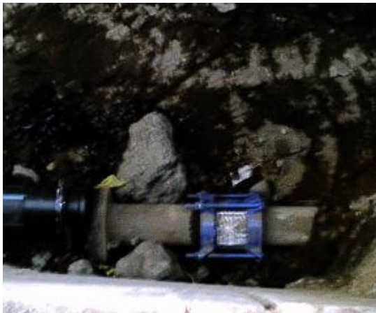
SECCIONAMIENTO CON ABRAZADERA (FOTOGRAFIA No 40)
