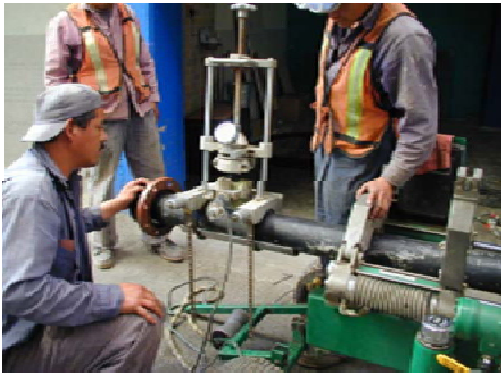
TERMOFUSIÓN DE SILETA MECÁNICA (FOTOGRAFIA No 55)
