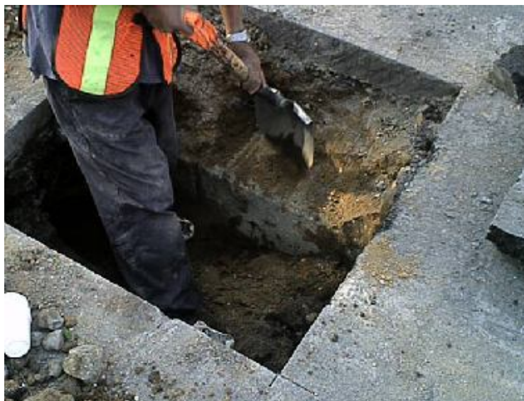
EXCAVACIÓN PARA VERIFICAR INSTALACIONES SUBTERRÁNEAS
