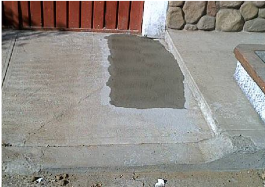
COLOCACIÓN CONCRETO HIDRÁULICO EN VENTANA DE BANQUETA
