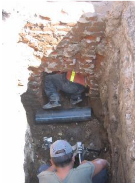
DEMOLICIÓN DE MURO
