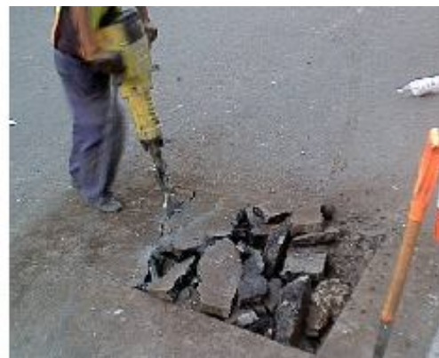
DEMOLICIÓN EN VENTANA DE ARROYO (FOTOGRAFÍA No 21)
