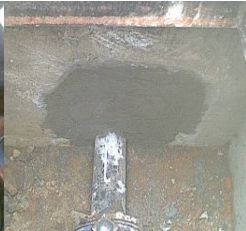
APLANADO DE MURO (FOTOGRAFIA No 69)
