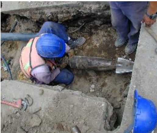
COLOCACIÓN DE NAVAJA Y AMPLIADOR (FOTOGRAFIA No 49)
