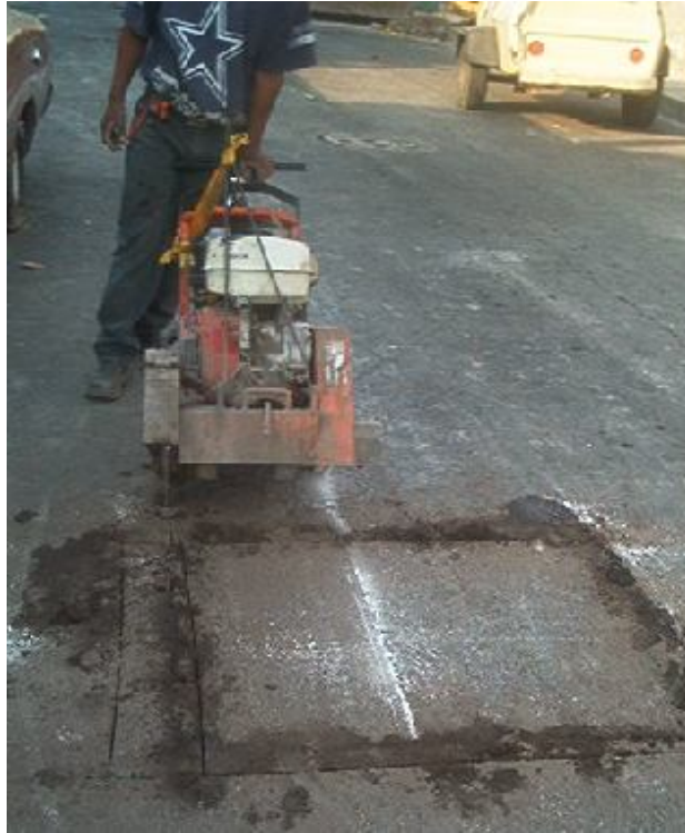
CORTE DE PAVIMENTO EN VENTANA DE ARROYO
