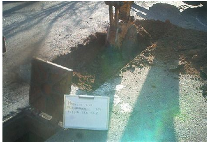
EXCAVACIÓN A MÁQUINA EN VENTANA DE LANZAMIENTO (FOTOGRAFIA No 24)
