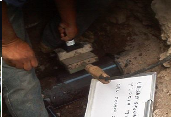
TERMOFUSIÓN DE SILETA MANUAL (FOTOGRAFIA No 56)
