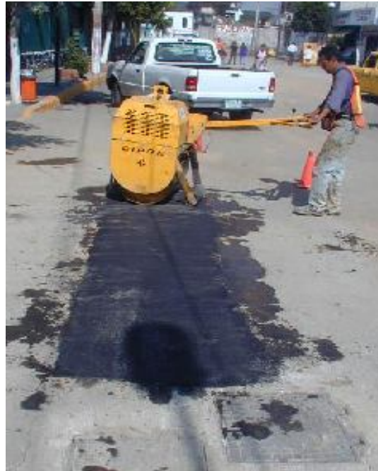
COMPACTACIÓN DE MEZCLA ASFÁLTICA
