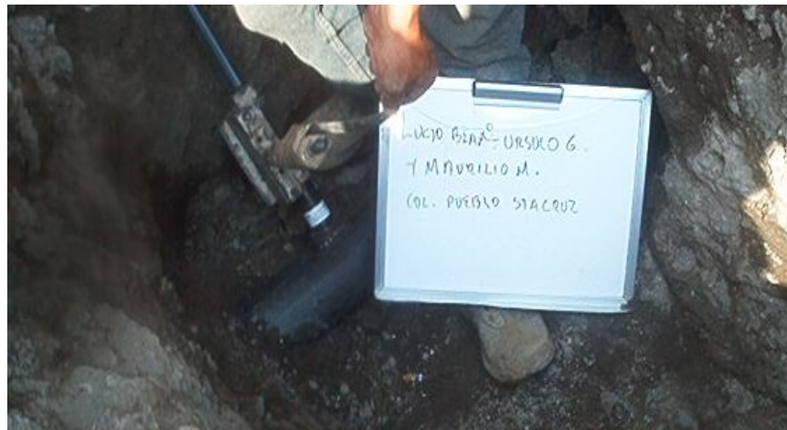
TERMOFUSIÓN DE TUBERÍA PARA RAMAL
