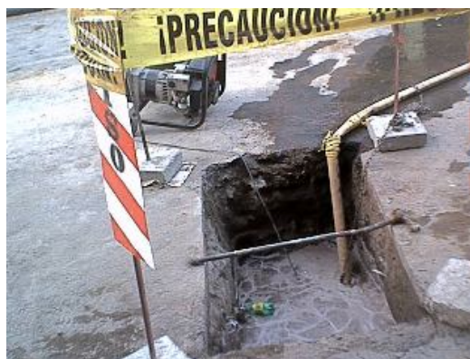
BOMBEO DE ACHIQUE EN VENTANA DE LANZAMIENTO
