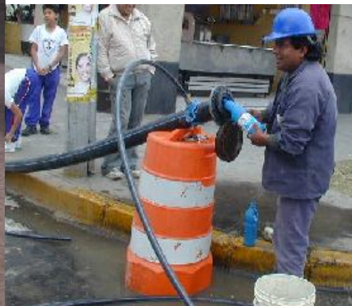
DESINFECCIÓN DE TUBERÍA (FOTOGRAFIA No 36)
