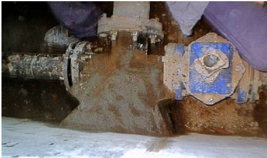
COLOCACIÓN DE ATRAQUE EN TEE DE FO.FO.
