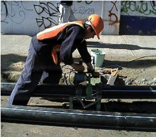
COLOCACIÓN DE CAREADOR (FOTOGRAFIA No 31)
