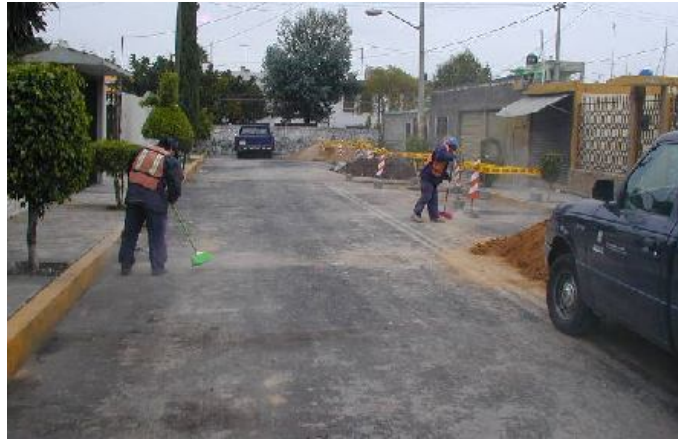
BARRIDO FINO DE LA OBRA
