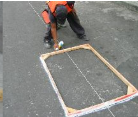
TRAZO EN VENTANA DE ARROYO (FOTOGRAFIA No 17)
