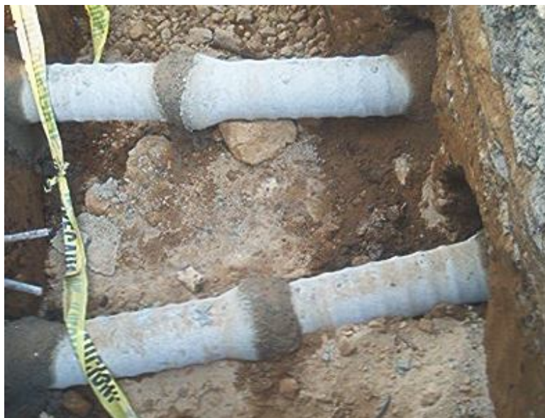
REPARACIÓN DE DESCARGAS DOMICILIARIAS AGUAS NEGRAS
