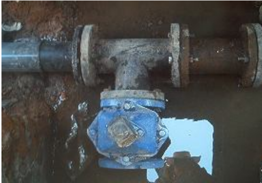
SUSTITUCIÓN DE VÁLVULA (FOTOGRAFÍA No 63)
