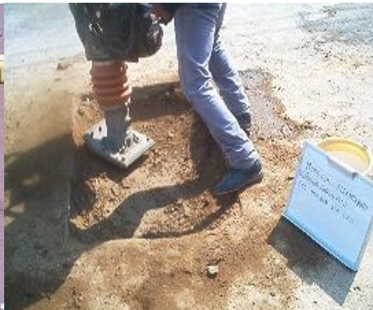
COMPACTACION ARROYO VEHICULAR (FOTOGRAFIA No 72).
