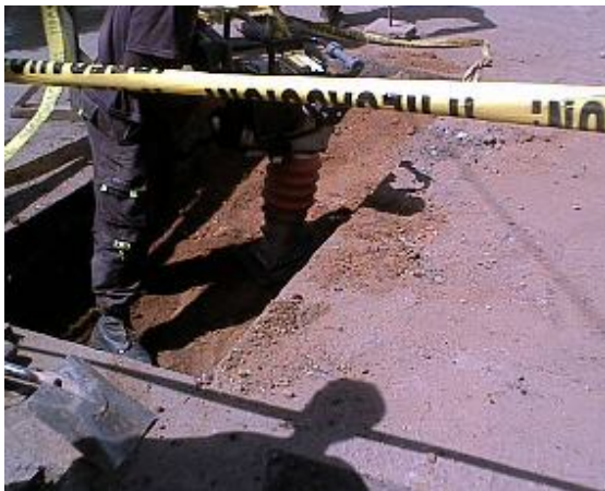
RELLENO Y COMPACTACIÓN EN VENTANA (FOTOGRAFIA No 71)
