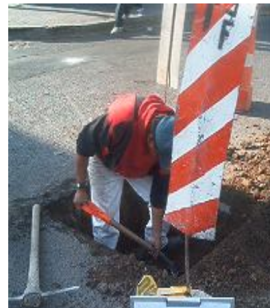
EXCAVACIÓN MANUAL EN VENTANA (FOTOGRAFIA No 23)
