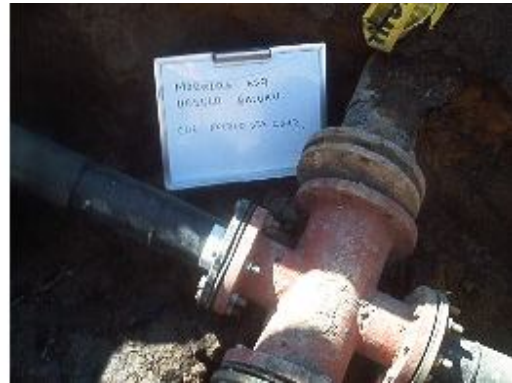
SUSTITUCIÓN DE CRUZ DE FO.FO. (FOTOGRAFÍA No 64)
