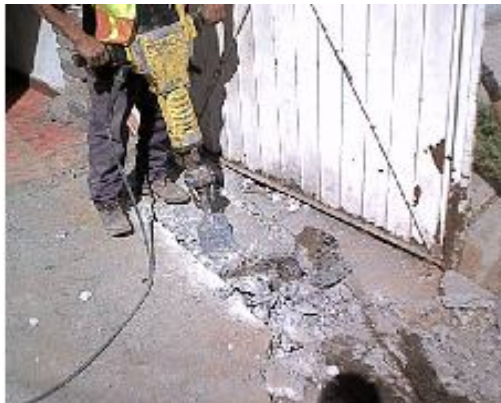
DEMOLICIÓN EN VENTANA DE BANQUETA (FOTOGRAFÍA No 20)
