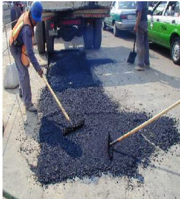
RASTRILLO DE MEZCLA ASFALTICA (FOTOGRAFIA No 77)
