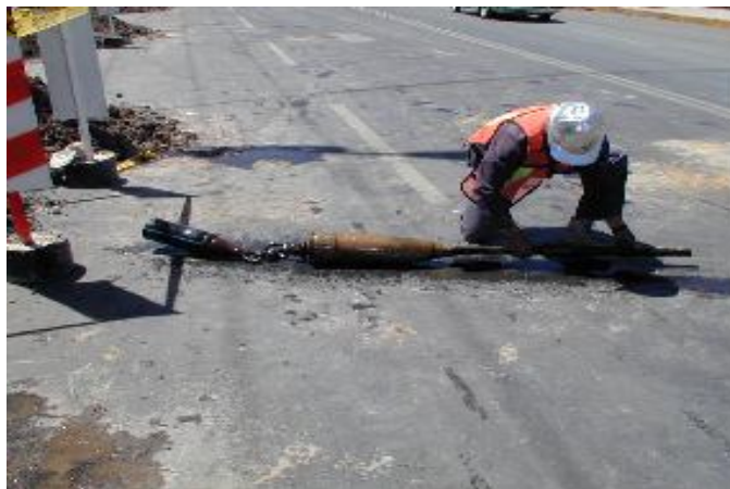
EXPANSOR, AMPLIADOR DE RUPTURA Y NAVAJA CORTADORA EN "V"
