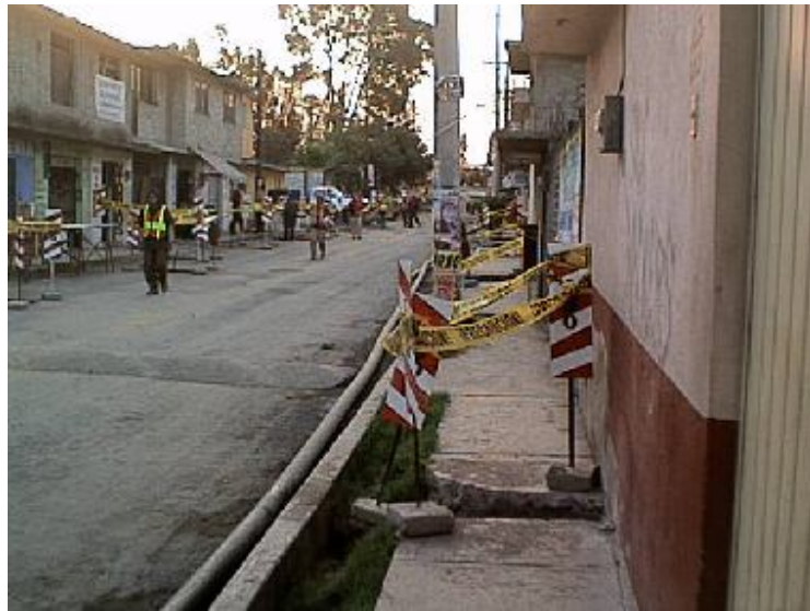
SEÑALIZACIÓN EN VENTANAS DE BANQUETA Y ARROYO
