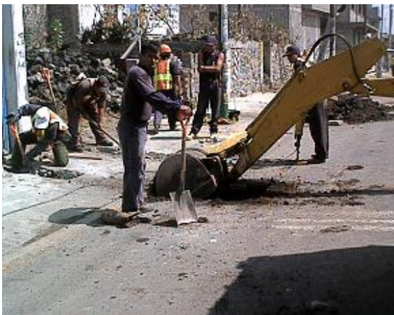
EXCAVACIÓN A MAQUINA EN ARROYO (FOTOGRAFIA No 22)
