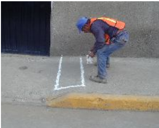
TRAZO EN VENTANA DE BANQUETA (FOTOGRAFIA No 16)
