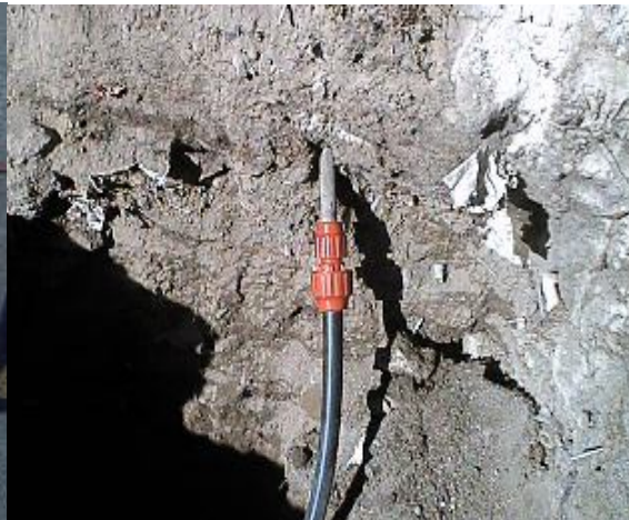
CONEXIÓN SIN VERTICAL (FOTOGRAFIA No 60)
