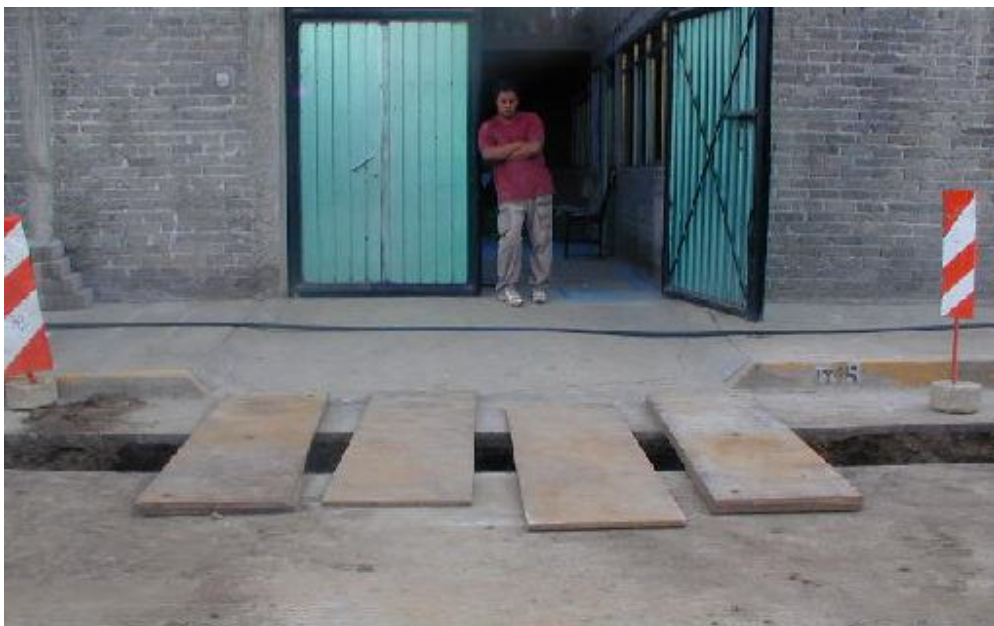
COLOCACIÓN DE PLACAS PARA PASO PEATONAL Y VEHICULAR
