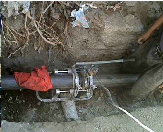
COLOCACIÓN DE CALENTADOR (FOTOGRAFIA No 32)
