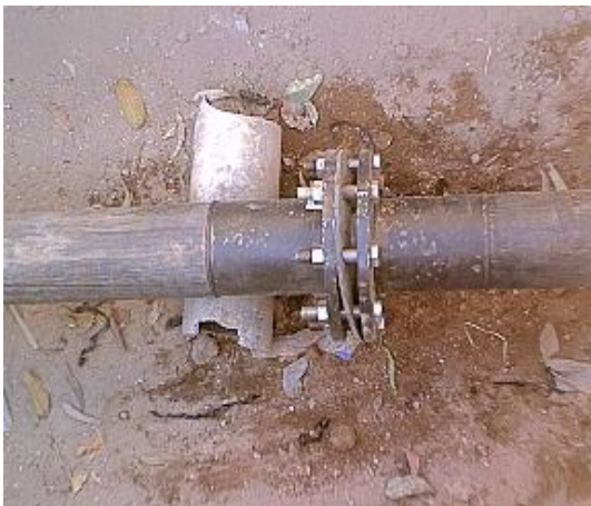
UNIÓN BRIDADA INTERMEDIA (FOTOGRAFÍA No 65)
