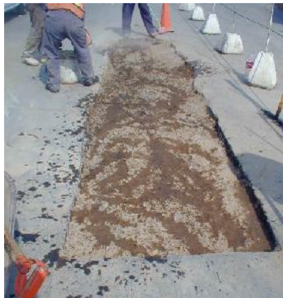
CAJEO EN VENTANA DE LANZAMIENTO
