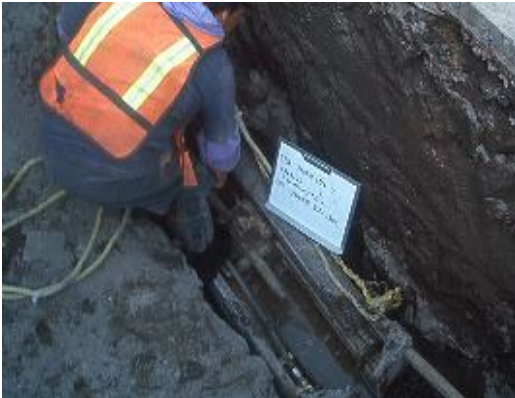
COLOCACIÓN DE UNIDAD DE IMPULSO (FOTOGRAFIA No 47)
