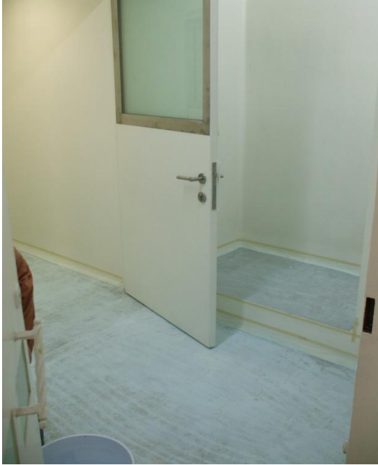
Foto 1. Preparación de piso para el acabado sanitario
