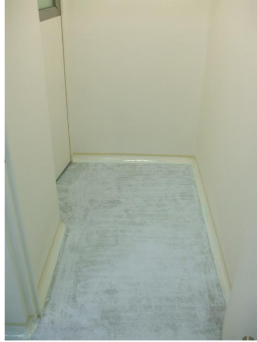
Foto 2. Preparación de piso para pintura vinílica
