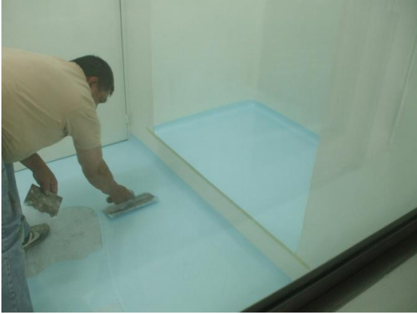
Foto 5. Aplicación de pintura vinilica a clase C
