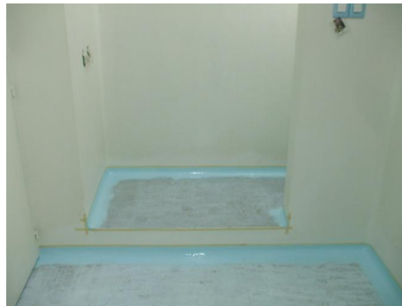
Foto 4. Aplicación de pintura en acabado sanitario
