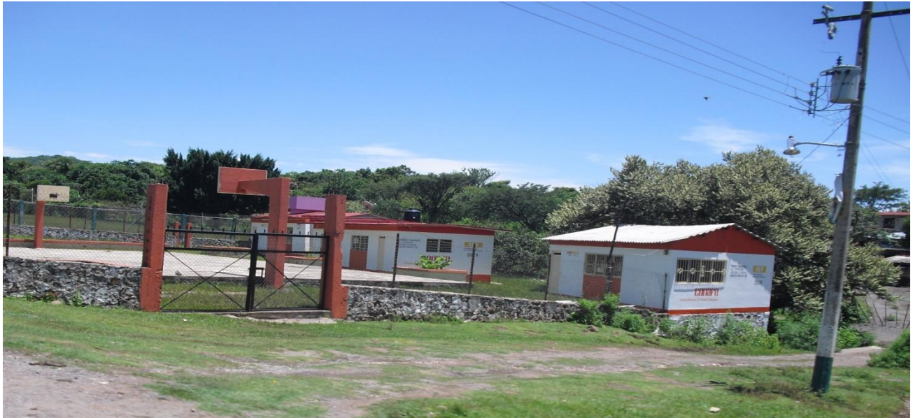
Figura 5. Escuelas primaria (lado derecho), secundaria (lado izquierdo) y alumbrado publico de la comunidad
