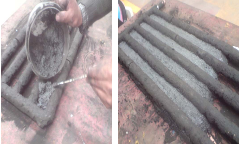
RELLENANDO LOS ESPACIOS DE LOS TUBOS
