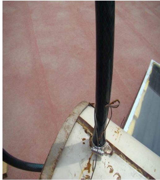
INSTALACIÓN DE LA MANGUERA
