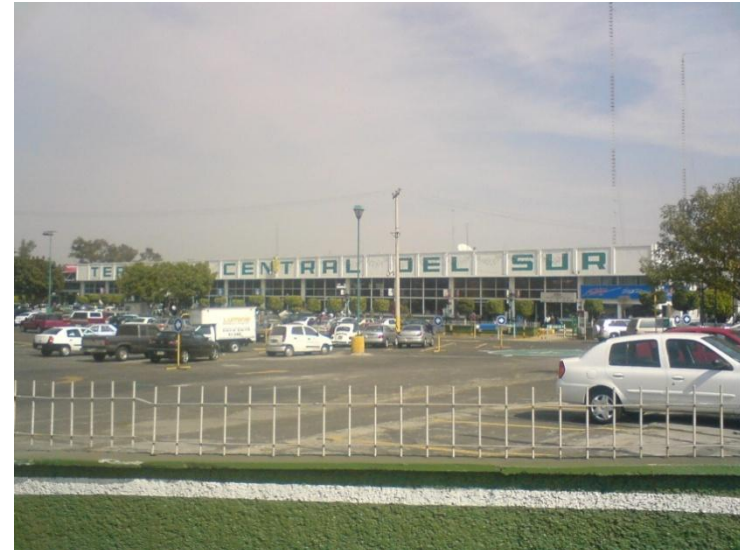
Fachada principal de la Terminal Central del Sur. Vista desde Tasqueña
