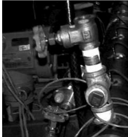
Figura 3.8: Válvula de bola para entrada de agua de enfriamiento.
