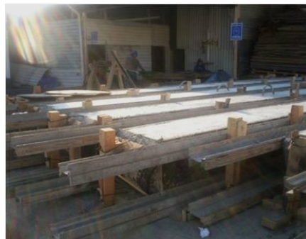
Almacén de herramientas y cama de curado de los pilotes
