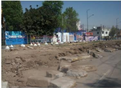
Demolición de guarniciones y banquetas
