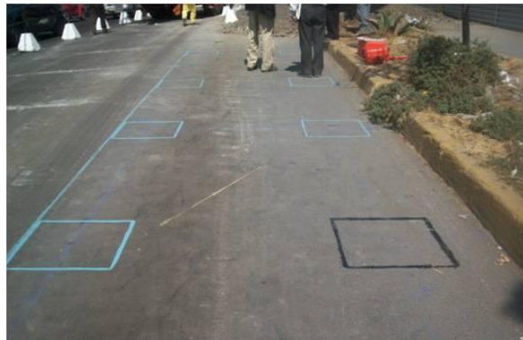
Fig. 3.1. Puntos de ubicación para el hincado de pilotes
