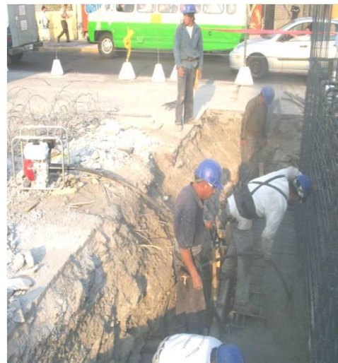
Fig. 3.26. Vibrado
