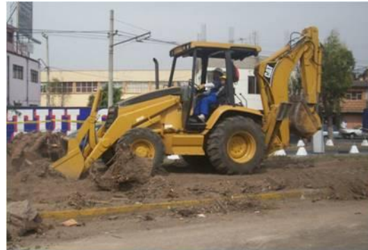
Retiro de la demolición
