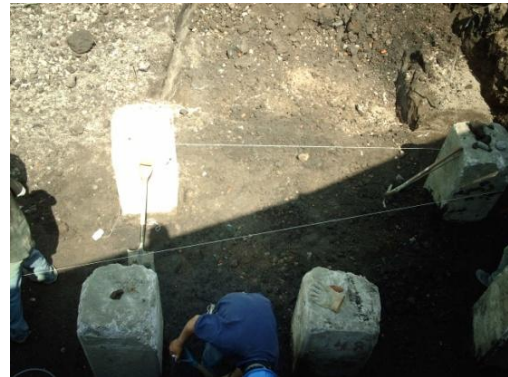
Fig. 3.15. Brigada topográfica en las zapatas
