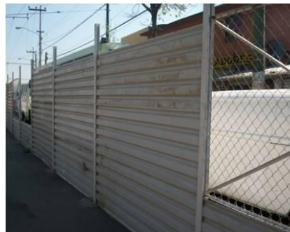
Colocación de muros metálicos
