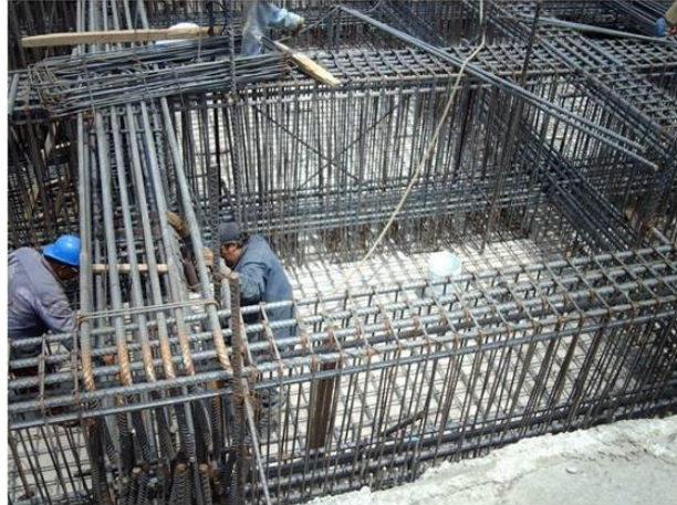
Fig. 3.23. Habilitado de acero de refuerzo en zapatas
