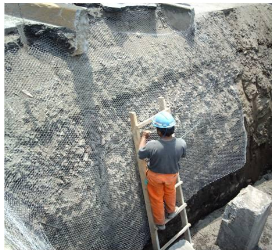
3.12(b). Concreto lanzado para evitar caídos
