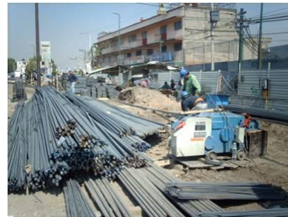
Taller de habilitado para los pilotes
