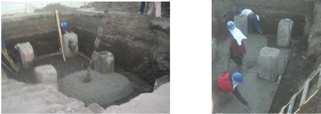
Fig. 3.16. Colocación de plantilla en el fondo de la zapata (+5.0 cm de espesor)
