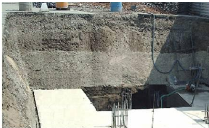
Fig. 3.22. Plantilla y demolición de pilotes terminado.
