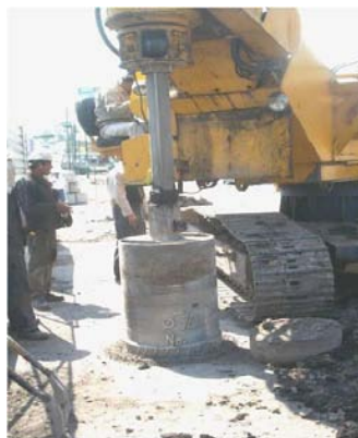
Fig. 3.3. Perforadora circular montada sobre orugas
