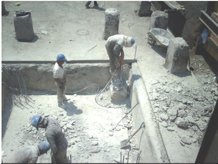
Fig. 3.21. Descabece de Pilotes
