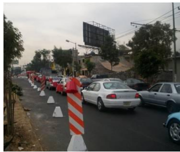
Colocación de bollas y cordones para el confinamiento
