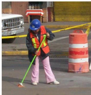
Trabajos de limpieza
