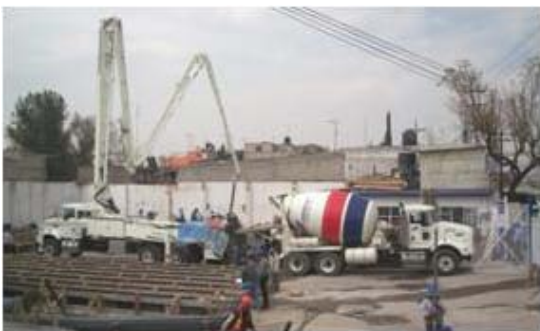
2.8 (a) Colado de Pilotes
