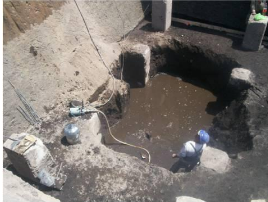
3.14. Bombeo de achique
