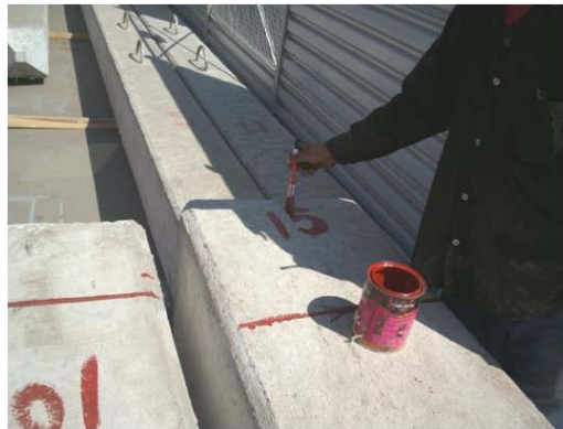
Fig. 2.12. Marcado de Pilotes
