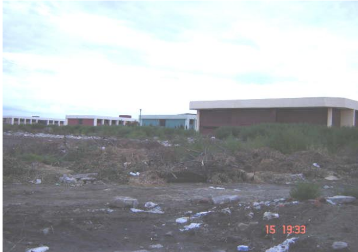
Interior de terreno lado norte
