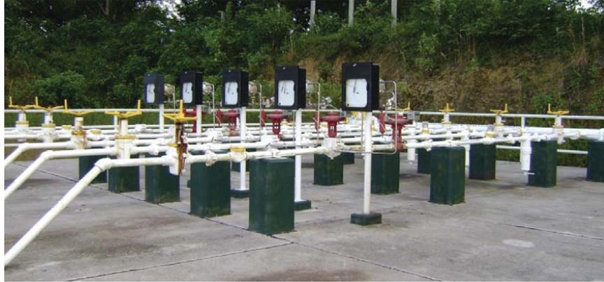
**Figura 30. Manifold de inyección de gas**
