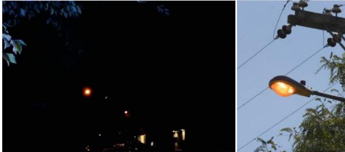
Imagen 9 - Izquierda: La oscuridad, una constante en el conjunto. Derecha: Debido a fotoceldas descompuestas, algunas luminarias funcionan incluso de día.
