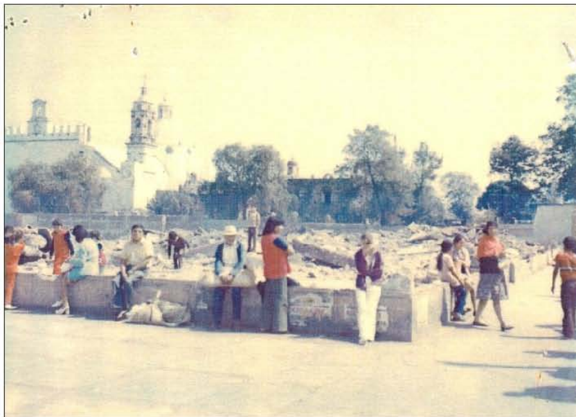
Imágenes 77. Vista tomada del lado poniente, y 78, vista tomada del ángulo Sur-Oeste del atrio, donde se puede apreciar los escombros producto de las liberaciones de 1974 (véanse imágenes 79, 80 y 81). Expediente del convento de San Bernardino de Siena, Xochimilco, DGSMP, Conaculta, 5 de noviembre de 1974.
