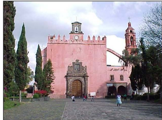
Imagen 11. San Bernardino de Siena, 15 de noviembre 2002, Nótese el color de la fachada (en rosa), que difiere del propuesto en 2005 (amarillo). Fuente: Archivo particular de Fernando Roberto Chiapa Sánchez.
