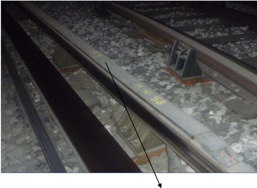
Fig.2.2 Cable piloto sobre la barra guía (tapiz) canaleta de leucoleno.
