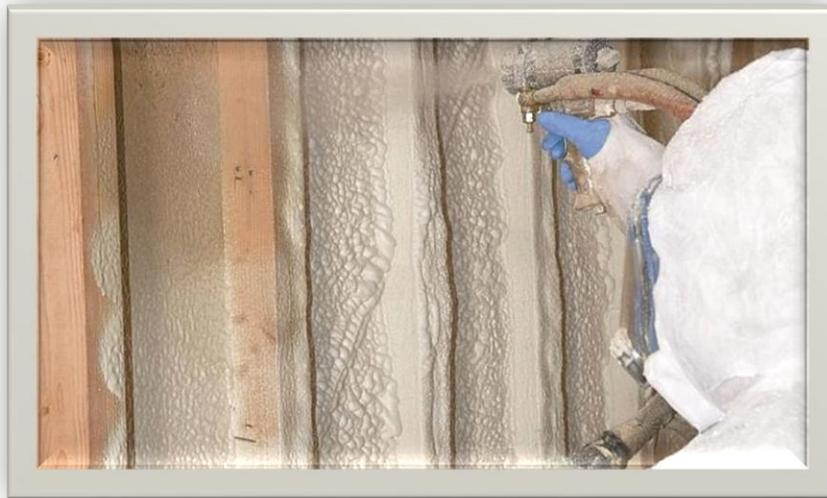
**Fig. N° 15 Aplicación de Espuma de Poliuretano**
