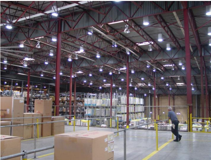
FIG. III. 9 Iluminación en almacén.
