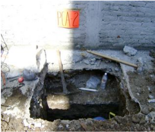
EN LA FOTO SE OBSERVA EL EDIFICIO DE CUATRO NIVELES QUE EXISTE EN LA COLINDANCIA NORTE Y DONDE SU CIMENTACIÓN ESTA CONSTITUIDA POR UN CAJÓN DE CONCRETO ARMADO
