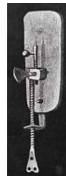
Primer microscopio de una lente inventado por Leeuwenhoek.
