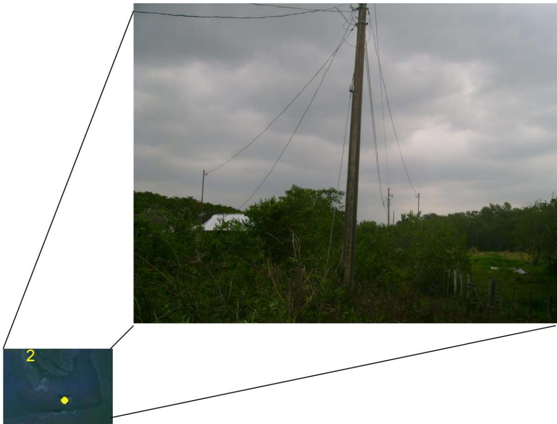
Figura 7. Tendido de cableado eléctrico en costa de San Juan.
