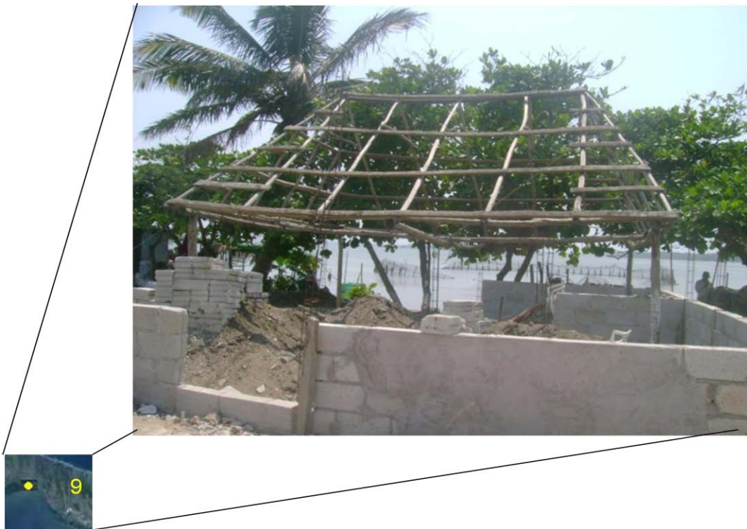
Figura 28. Armazón del techo en Arbolillo
