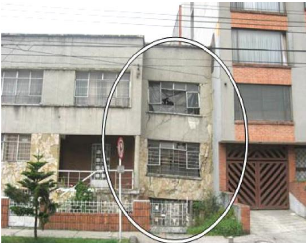
Foto 1. Vivienda colindante afectado por una edificación de cinco niveles.
