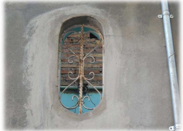
Fotografía No. 23 Ventana con geometría rectangular vertical y semicircular en ambos extremos.
