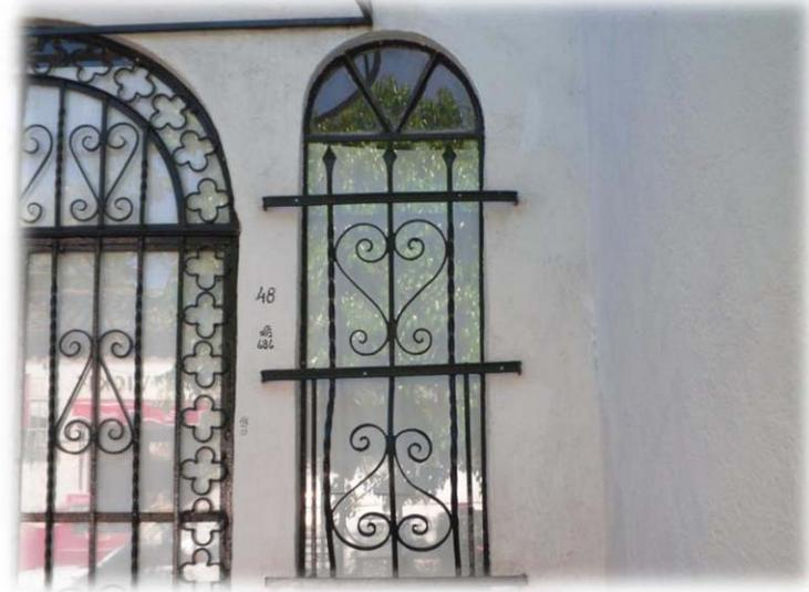
Fotografía No. 19 Ventana con geometría rectangular vertical y semicircular (0.50 x 1.50m).
