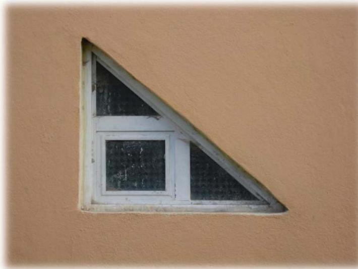
Fotografía No. 26 Ventana triangular (0.60m de base y 0.50m de alto)
