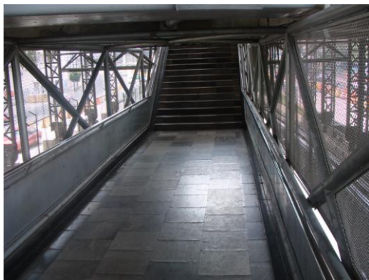
Figure 63 Pasillo del Metro Consulado
