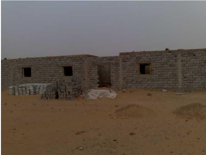
Figure 57 imagen subida en el sitio sobre la construcción de una escuela de música en 27 de febrero para la formación de jóvenes saharauis en el ámbito musical
