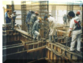
Colado y vibrado de contratraves de concreto premezclado Proy. Calz. Tlalpan #1179.
