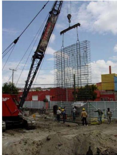
Colocación de armado de acero para muro Milán Mirador Polanco.
