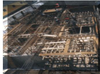
Vista general de armado de losa de cimentación . Proy. Calz de Tlalpan #1179.
