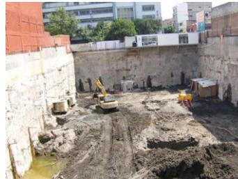
Excavación de terreno con muro Milán circundante anclado Mirador Polanco
